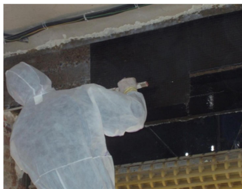
Obr. 2.1.2: Zosilnenie pomocou dodatočne lepených tkanín [5]
