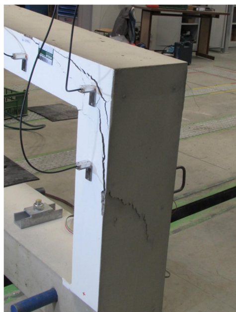
Obr. 5.4.6: ŽB A – porušenie prvku
