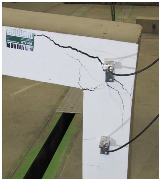
Obr. 5.4.8: GFRP A - II – rozvoj trhlín 2
