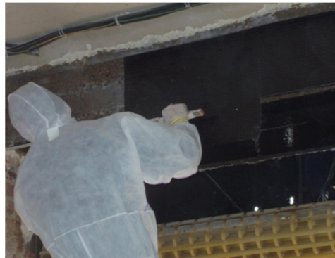
Obr. 2.1.2: Zosilnenie pomocou dodatočne lepených tkanín [5]
