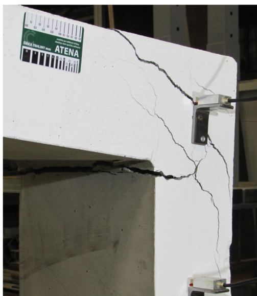
Obr. 5.4.9: GFRP A - III – porušenie prvku
