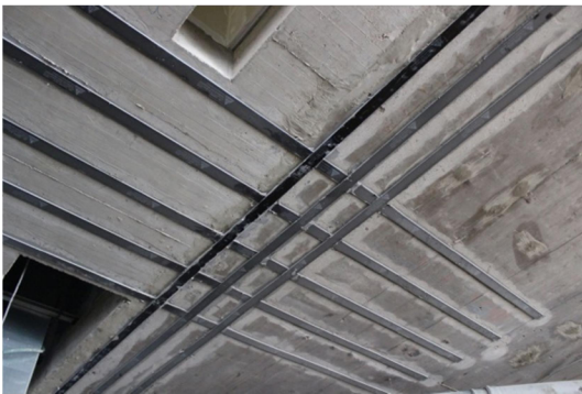
Obr. 2.1.1: Zosilnenie pomocou dodatočne lepených lamiel [6]
