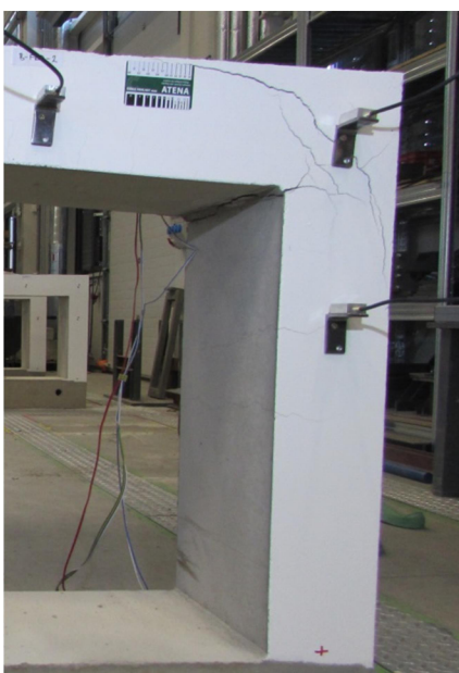
Obr. 5.4.17: GFRP B - II – rozvoj trhlín
