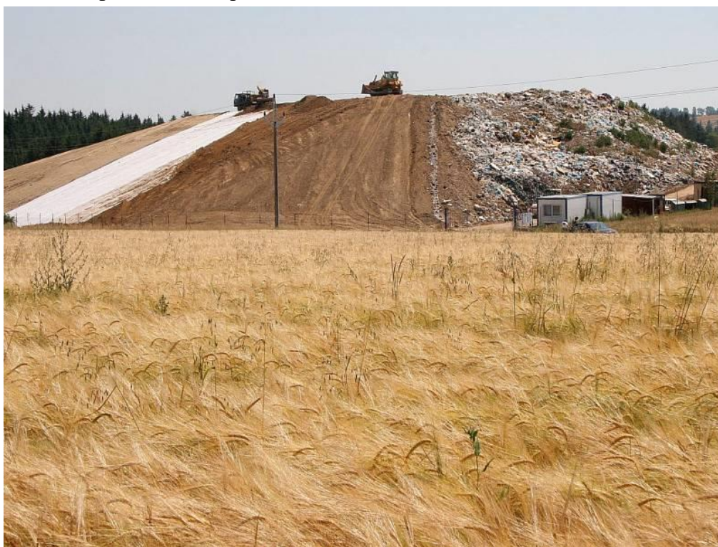
Obr. 1: Rekultivace skládky v Rožnově. Na skládkách je většinou k vidění vícero etap rekultivací zároveň, proto jsou pro ilustraci procesu nejvhodnější. Autor: Plíhal. Zdroj: https://havlickobrodsky.denik.cz/galerie/foto.html?mm=vyskytna_skladka_asa4835&s=36&back=2582302982
