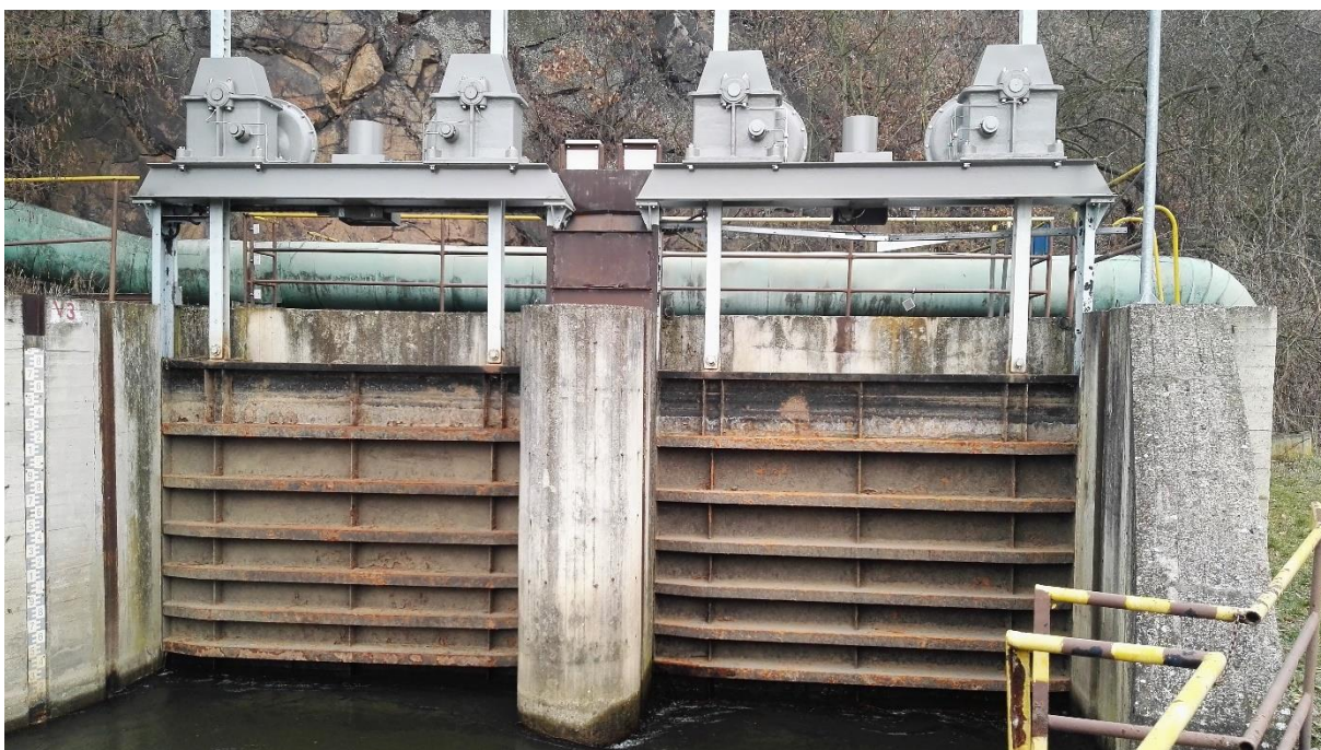
Obr. 17 Vtok MVE Želina; vlastní zdroj
