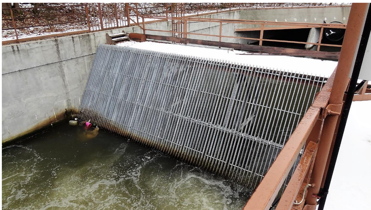
Obr. 18 Jemné česle Lomazického kanálu; vlastní zdroj
