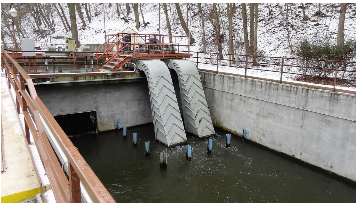
Obr. 20 Vírové turbíny MVE Želina; vlastní zdroj
