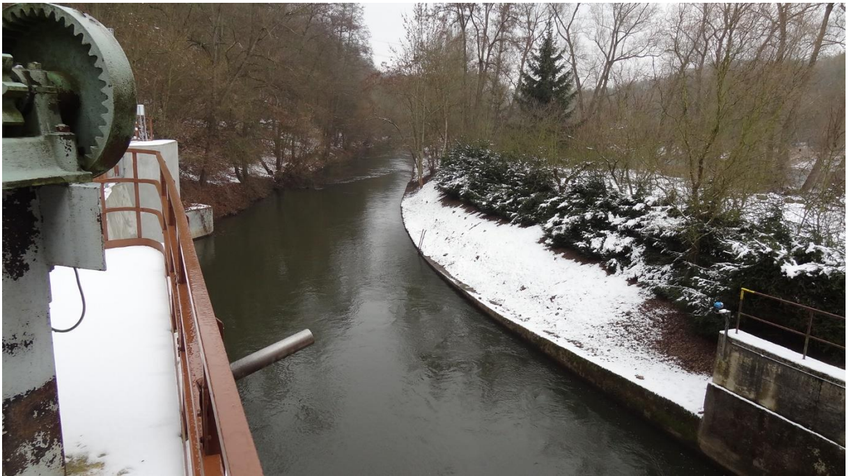
Příloha 3 Odpadní kanál MVE Želina
