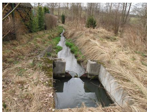
Obrázek číslo 21. Výpust z ČBV do Vlčího potoka
