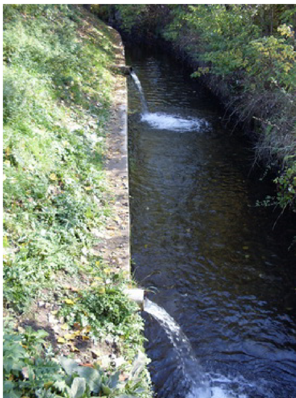
Obr. 4.1: Príklad výtoku odpadovej vody
