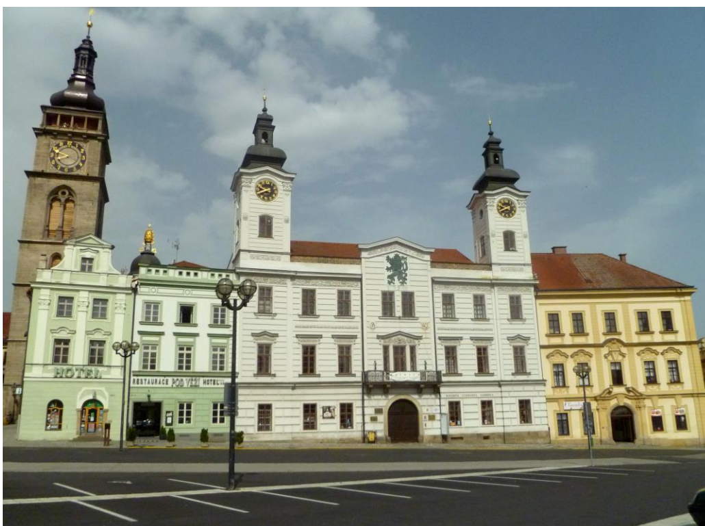
Příloha č. 15 - Současný stav radnice a okolních domů v roce 2019 (foto Petr Bártík).
