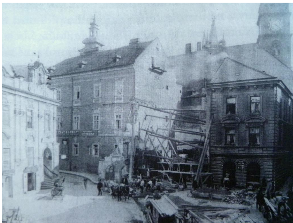
Příloha č. 13 - Demolice domů čp. 170 a 171 v roce 1909 (M. PENCÁK, Hradecký architekt, s. 70).
