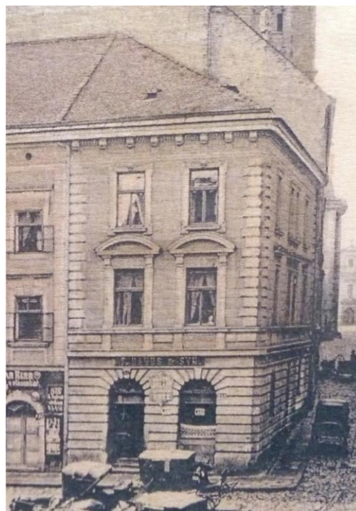
Obr. 7 - Dům čp. 169, stav před přestavbou v roce 1909 (dobová pohlednice).
