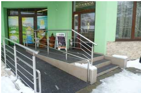
Obr. 16: Vchod do penziónu
