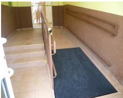
Obr. 6: Vstup do budovy pošty
