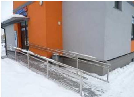
Obr. 4: Vchod do budovy
