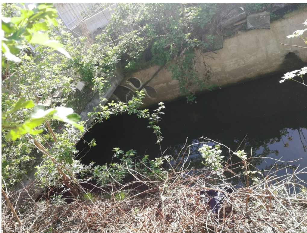
Obr. 51 Svitavský náhon na ulici Mlýnská tekoucí z tunelu
