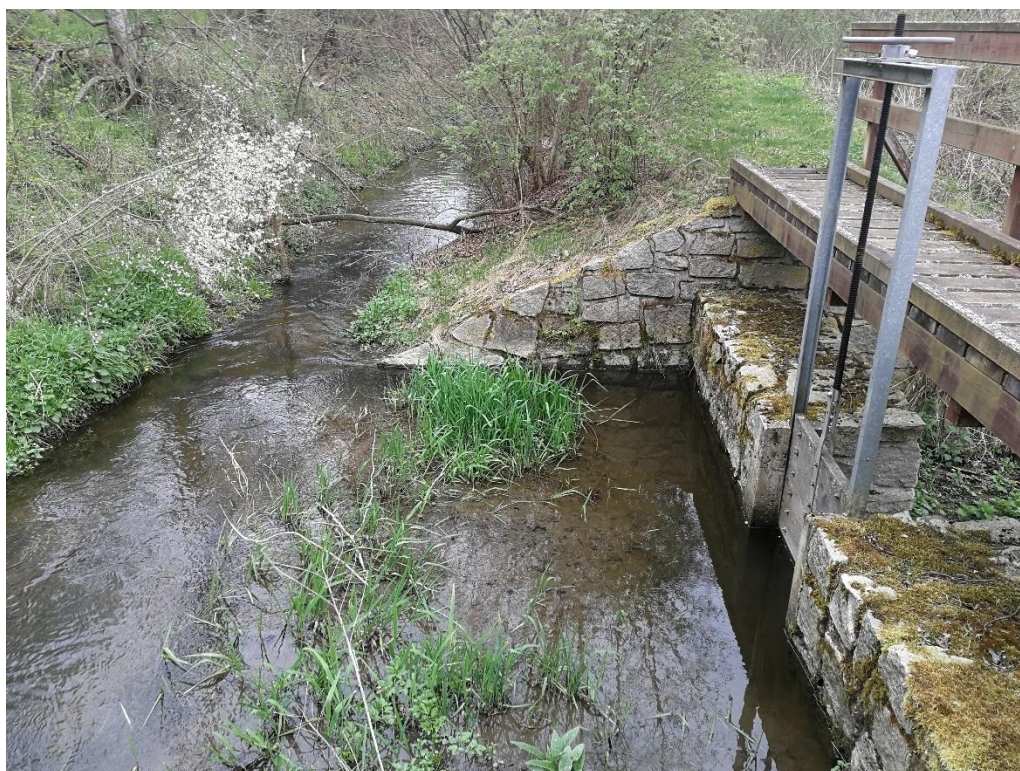
Obr. 40 Náhon a stavidlo k odlehčovacímu ramenu náhonu k Venclův mlýn
