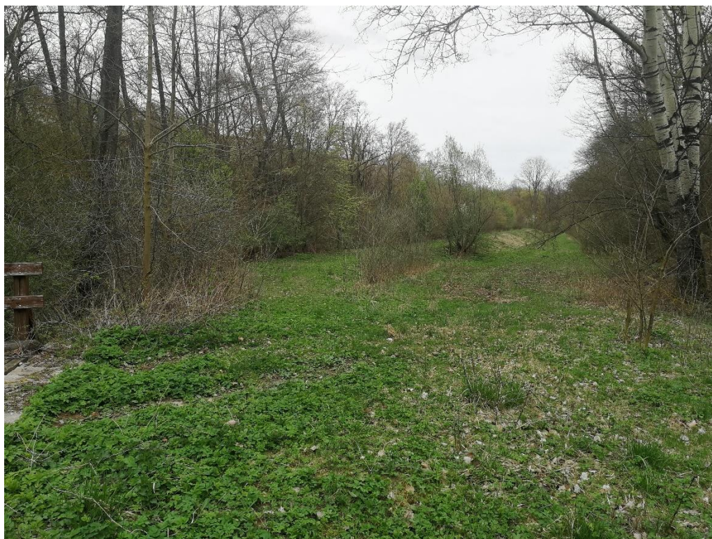
Obr. 42 Sypaná hráz náhonu k Venclův mlýn
