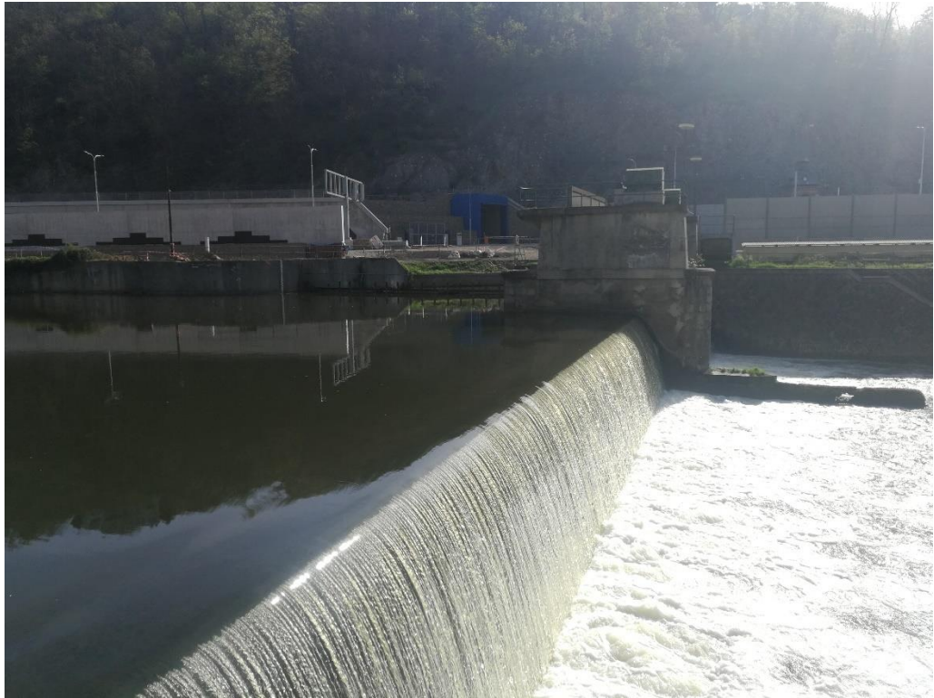
Obr. 59 Jez na Svratce za začátkem Svrateckého náhonu
