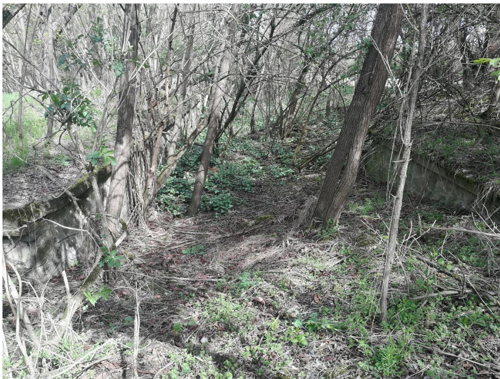
Obr. 7 Pozůstatky náhonu a stará zeď náhonu v obci Lechovice
