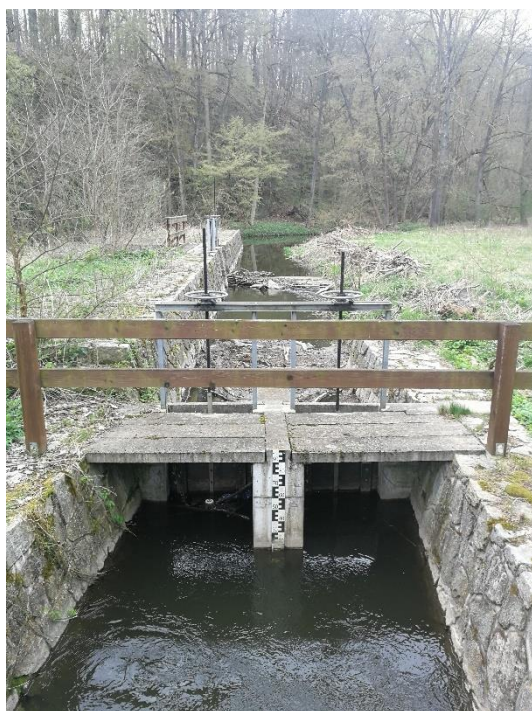
Obr. 41 Začátek náhonu se stavidlem a vodočtem k Venclův mlýn
