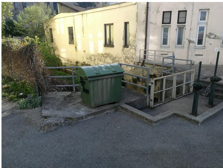
Obr. 50 Svitavský náhon na ulici Vlhká tekoucí do tunelu
