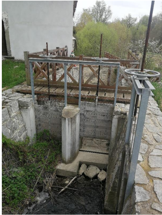
Obr. 35 Stavidlo na náhonu u Venclův mlýn
