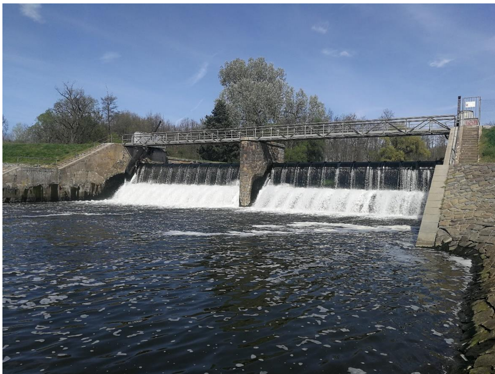
Obr. 61 Jez na Svatce za začátkem Vojkovického náhonu
