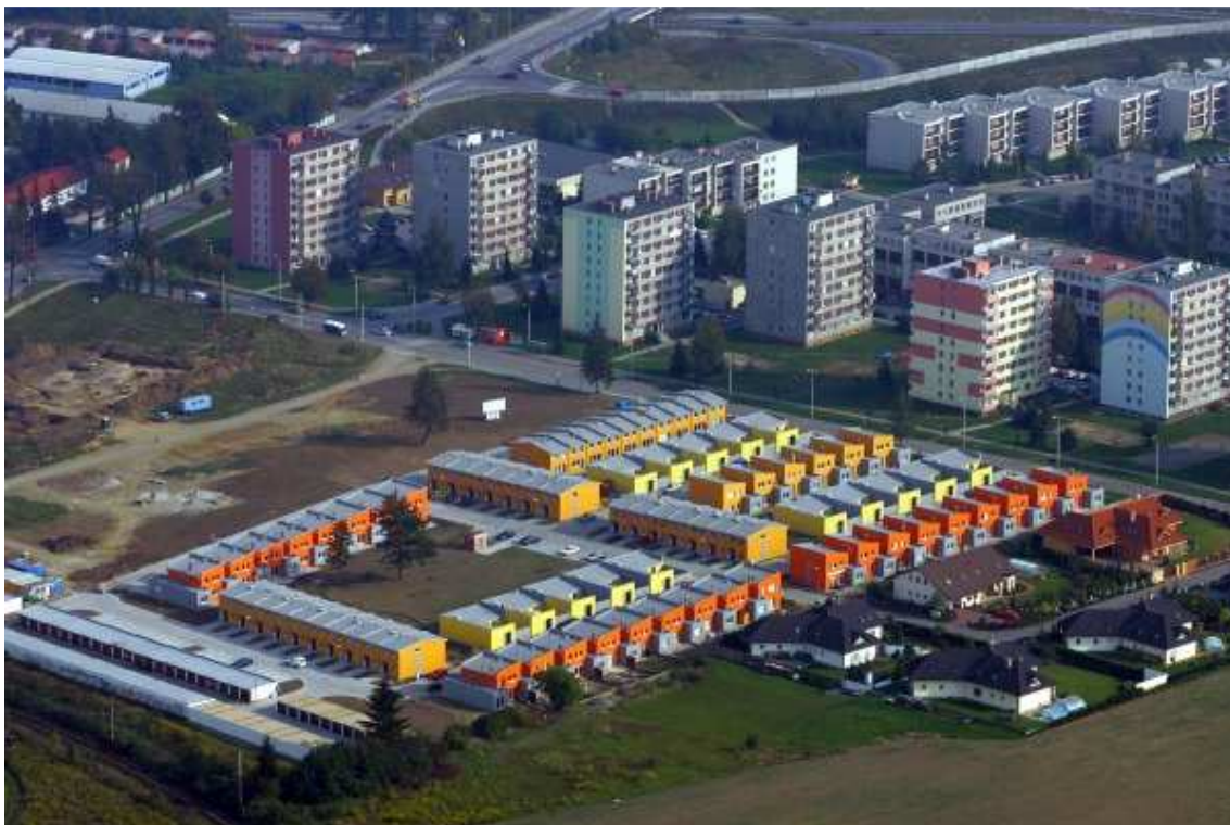
Obr. příl. č. 20 Řadové rodinné domy v lokalitě Na Dolině – CZ stavební holding Zdroj: CZ stavební holding, a. s., 2012
