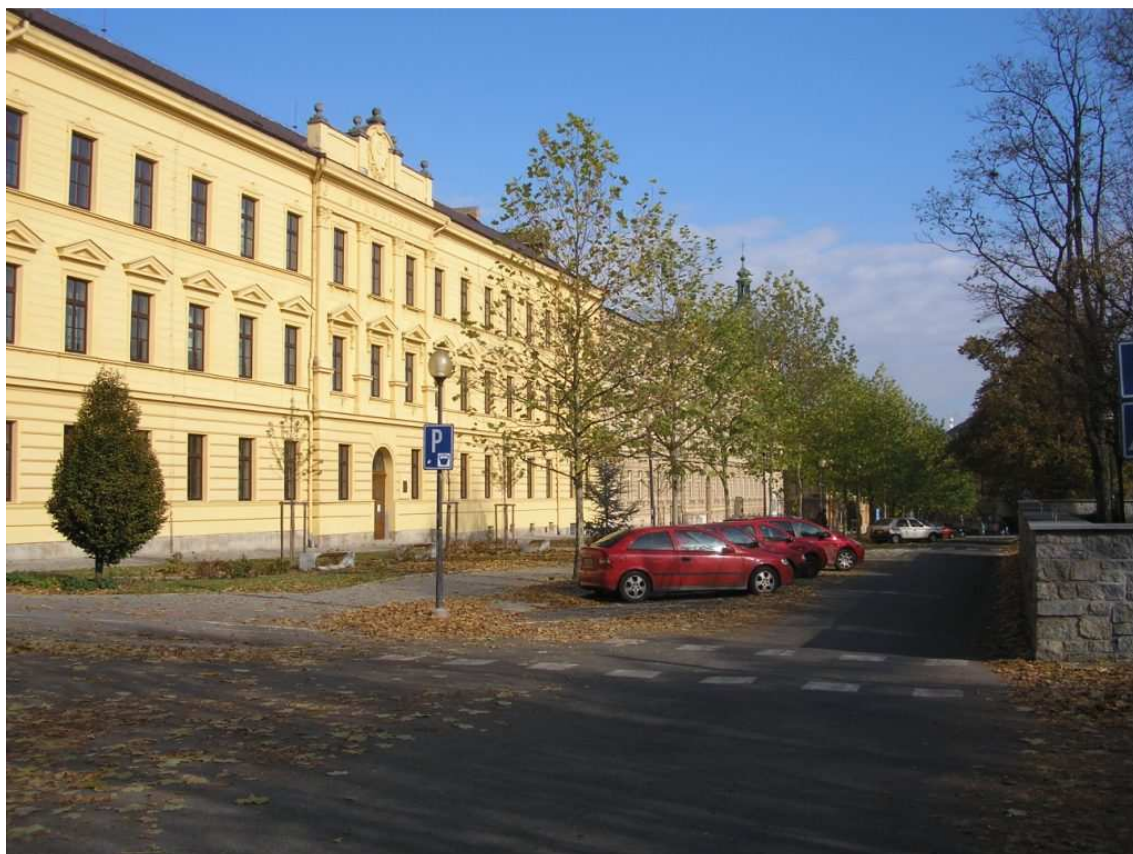
Obr. příl. č. 10 Alej na ulici Jana Masaryka – vlevo budovy Gymnázia Jihlava a Střední průmyslové školy Jihlava Zdroj: vlastní foto
