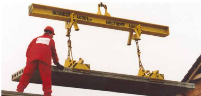
Obr. 6.7 Přeprava stropního dílce pomocí montážních samosvorných kleští
