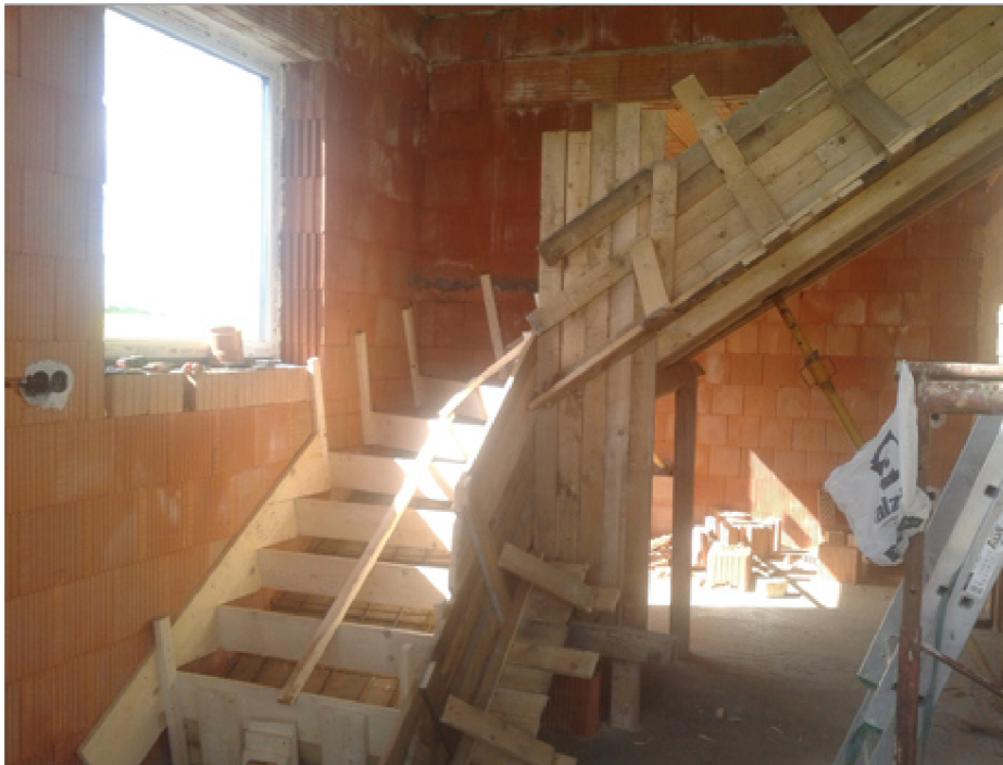
Obr. 6.3 Ilustrační obrázek bednění schodiště
