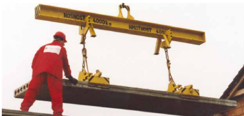
Obr. 6.7 Přeprava stropního dílce pomocí montážních samosvorných kleští
