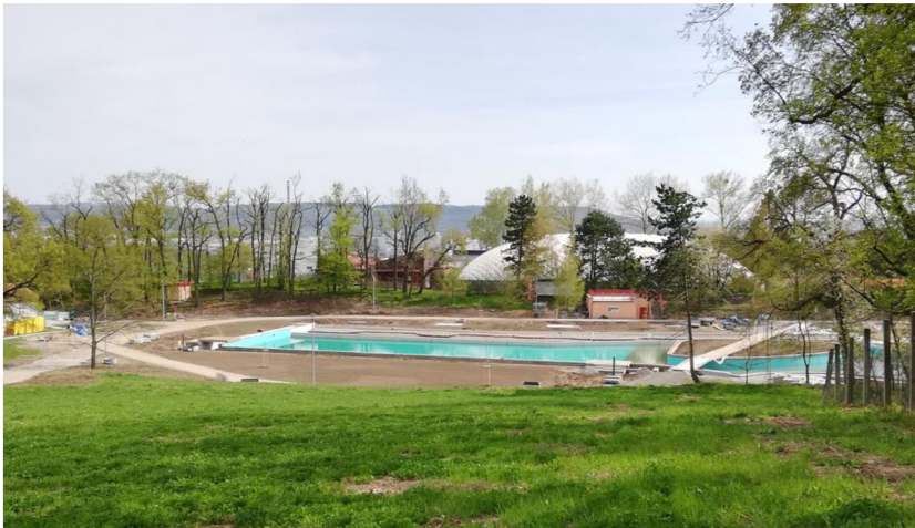
Obr. 43 Lokalita 6 – areál koupaliště, jaro 2022 probíhající rekonstrukce
