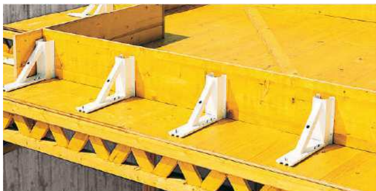
Obrázek 23 Bednění okraje stropní desky [25]
