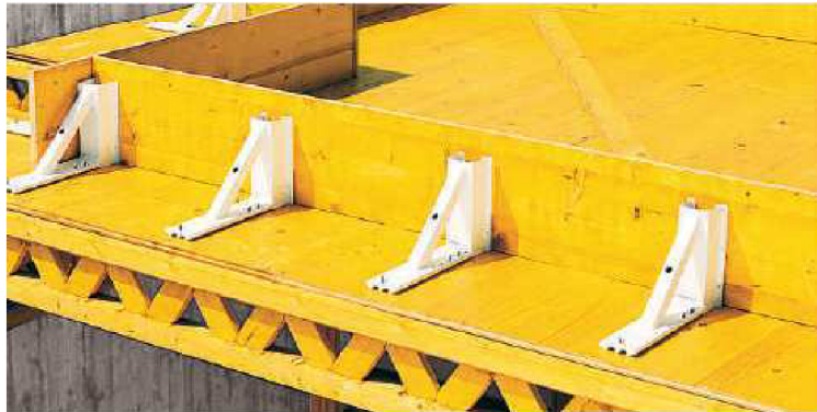
Obrázek 23 Bednění okraje stropní desky [25]
