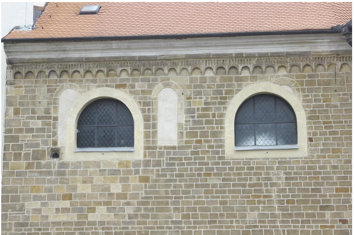
Původní zalděná okna a polomená okna novodobá. Obloučkový vlys.
