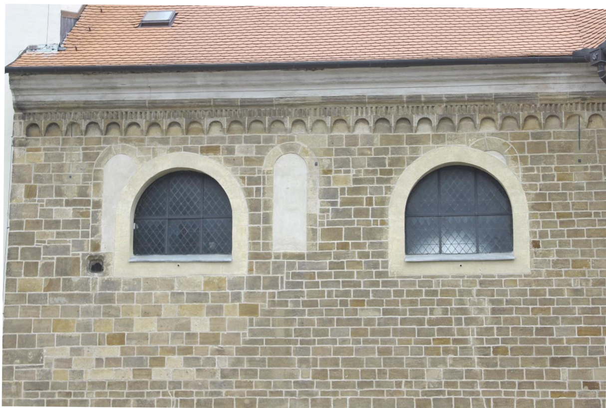
Původní zazděná okna a polomená okna novodobá. Obloučkový vlys.
