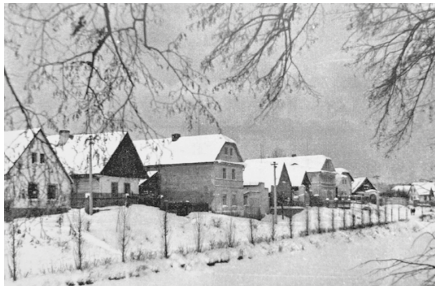
Obr. 17. Zimní pohled na řadu domů, jež byly pravděpodobně po požáru 1846 znovu postaveny (z knihy Hoškovicice, 2018)
