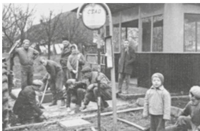
Obr. 37. Brigádníci při stavbě čekárny v roce 1950 (z knihy Hoškovice, 2018)
