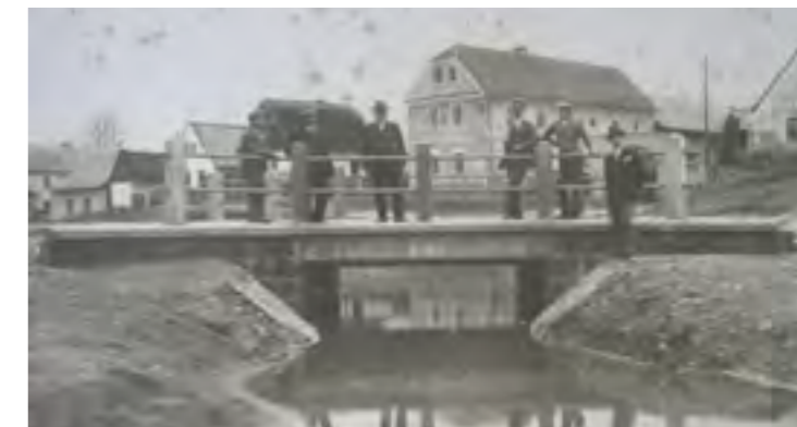
Obr. 30. Nový mostek přes strouhu roku 1926 (soukromý archiv)
