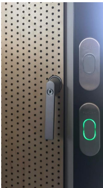
Obrázek 2: Ovládání žaluzií (nahore) a LED signalizace vzduchotechniky (dole) u větracího otvoru opatřeného klikou. (vlastní)
