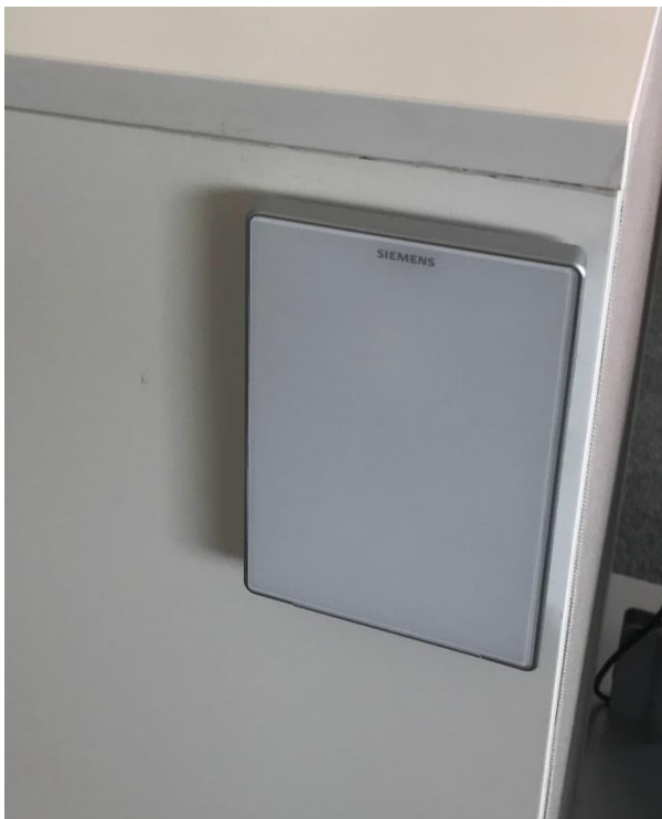
Obrázek 5: Zařízení pro měření teploty, vlhkosti a obsahu škodlivých látek ve vzduchu. (vlastní)
