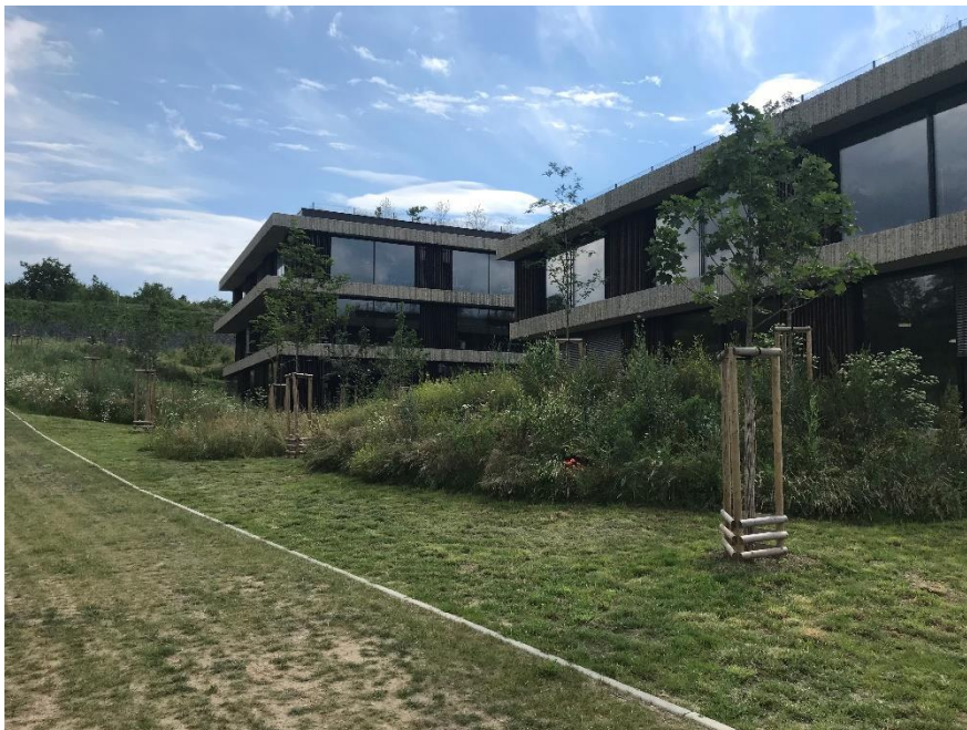
Obrázek 4: Začlenění budovy do terénu pomocí střešních zahrad a zvlnění okolního terénu. (vlastní)
