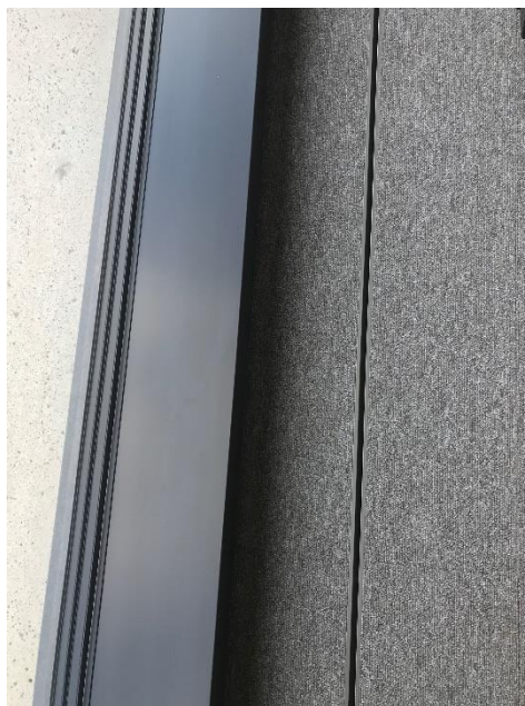
Obrázek 3: Podlahová šterbinová výústka přívodu čerstvého vzduchu. (vlastní)
