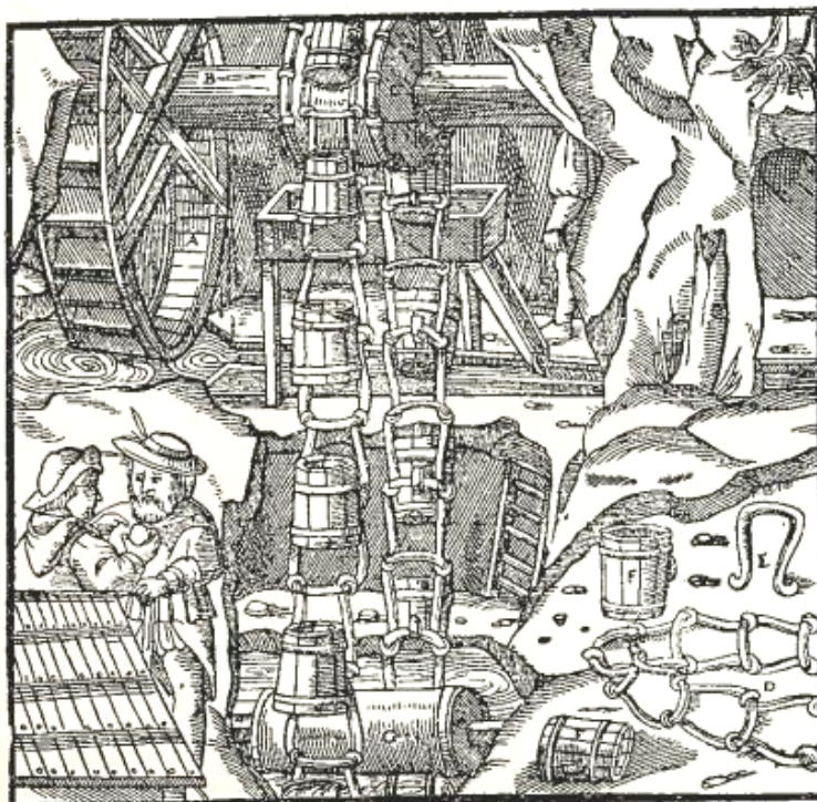
Vodní kolo na spodní vodu A. Hřidel B. Buben se zaraženými skobami C. Řetěz D. Článek E. Nádoby F. Spodní válec G.
