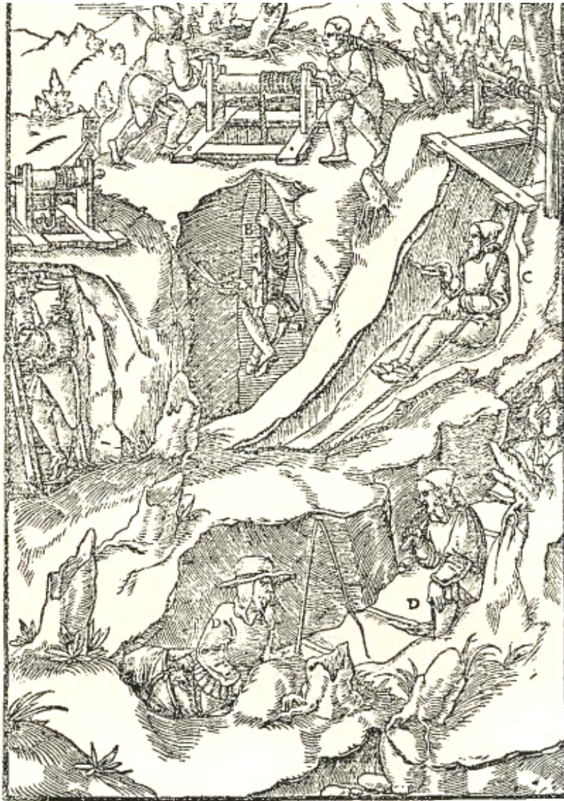
Po žebříku do šachet sestupující A. Na dřevěném valachu sedící B. Na kůži sedící C. Sestupující po schodech do skály vytesaných D.
