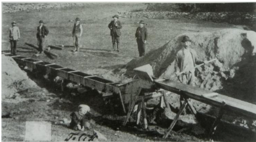
Obr. 17: Zařízení k pokusnému rýžování zlata z roku 1888 u obce Radešov (Fröhlich, 2006).
