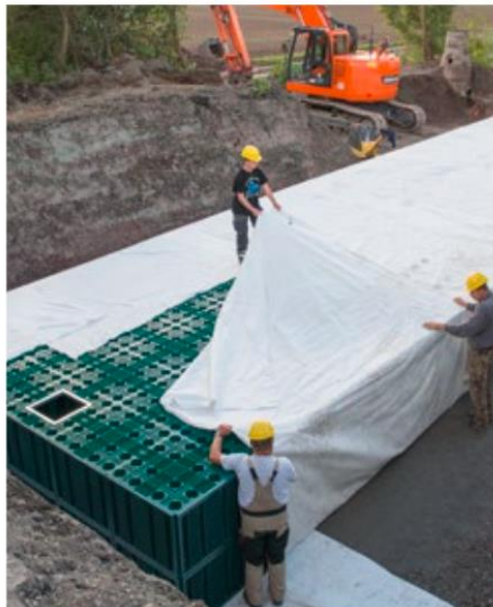
Obr. 138 Opláštění vsakovací nádrže geotextílií [163]
