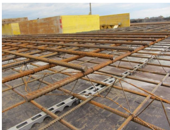
Obr. 109 Uložení ocelové výztuže [157]
