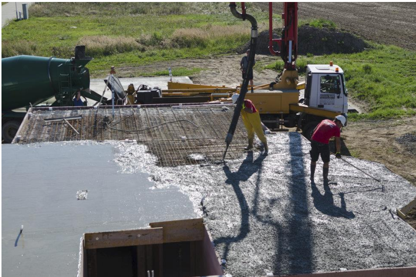
Obr. 110 Betonáž stropní desky [158]
