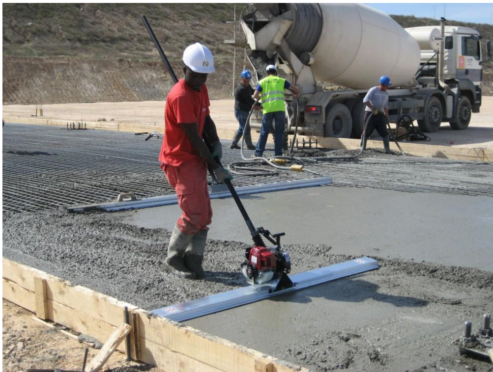
Obr. 111 Hutnění a urovňání čerstvé betonové směsi [160]
