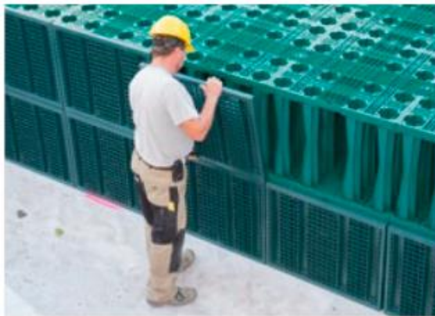
Obr. 136 Montáž bočních mřížek [163]
