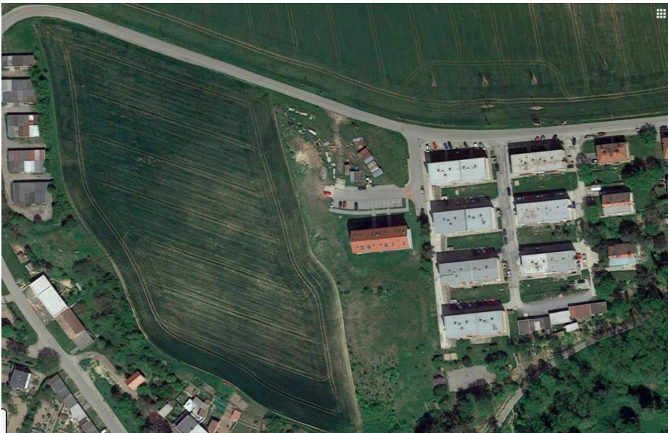
Obr. 18 Letecká fotografie budoucího staveniště [11]
