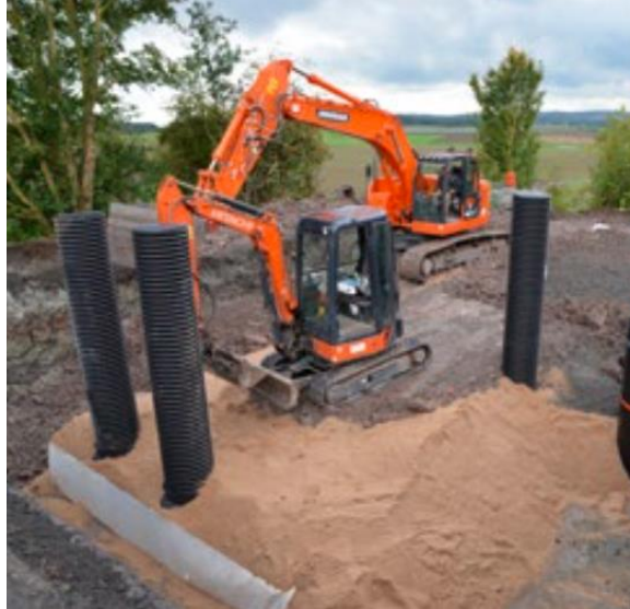
Obr. 139 Zásyp vsakovací nádrže [163]
