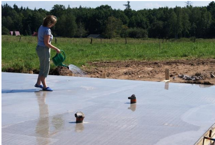
Obr. 113 Ošetřování betonu [162]
