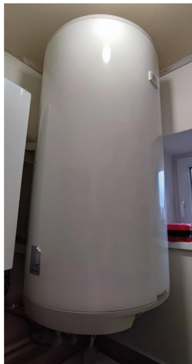
Obr. 8.5 Zásobníkový ohřivač vody
