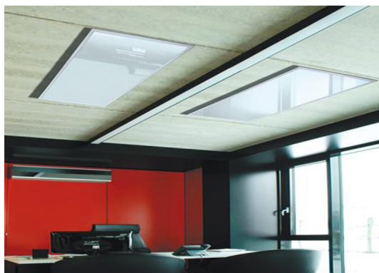
Obr. 3.7 Sálavý stropní panel [66]
