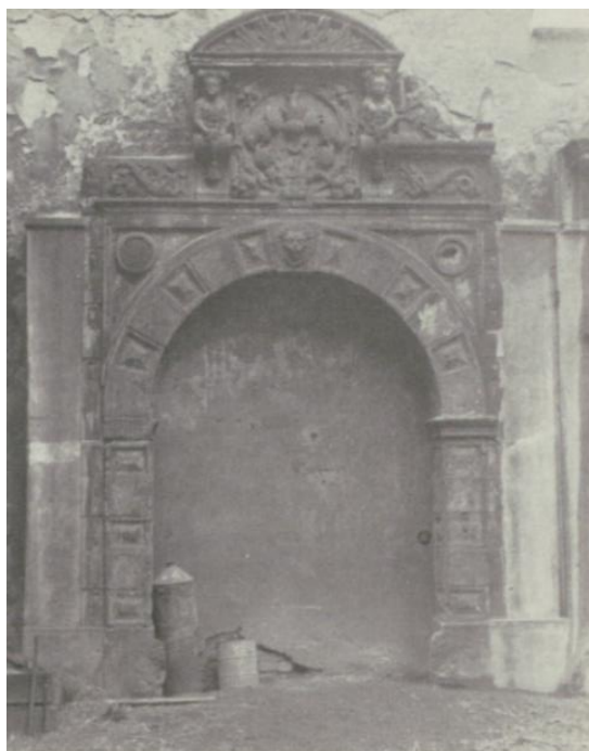
Obr. I. Přenesený portál z domu Náměstí Míru č. 13 do zdi dvora školy Na Hradě, po roce 1909
