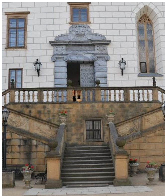
24 – Náměšť nad Oslavou, nádvoří zámku, portál, 2. polovina 16. století
