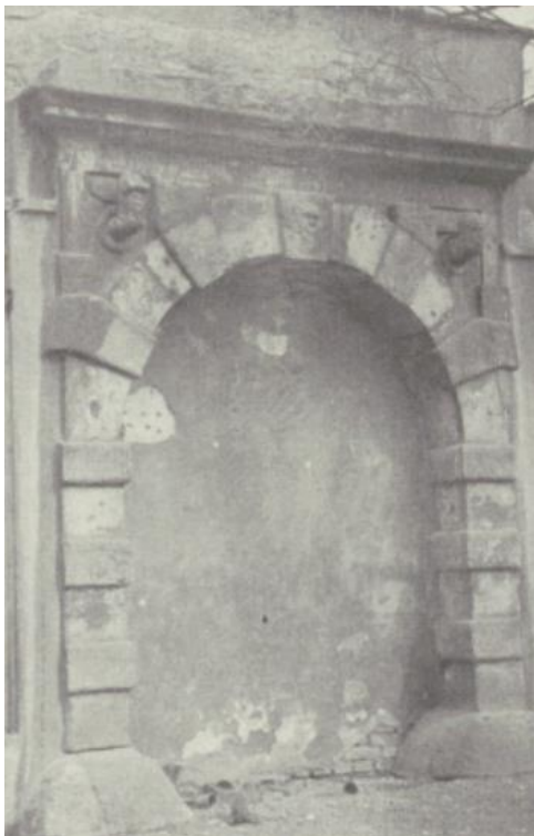
Obr. III. Přenesený portál z domu Náměstí Míru č. 12 do zdi dvora školy Na Hradě, po roce 1907
