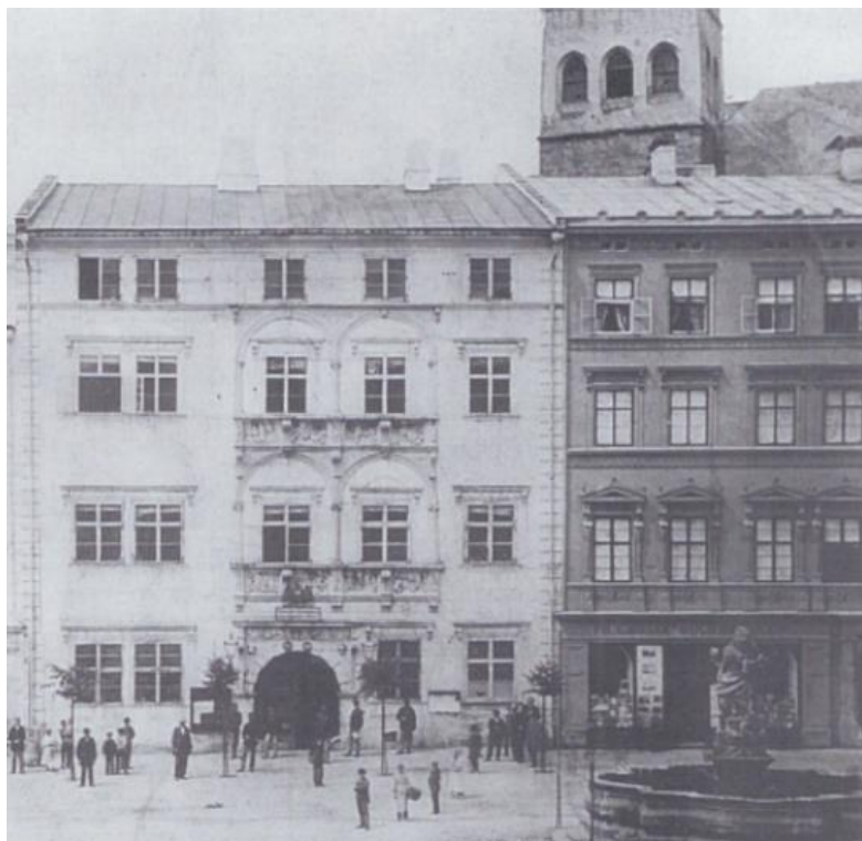
7 – Olomouc, Edelmannův palác č. 5, čp. 367, hlavní průčelí, 1864, stav před adaptací
