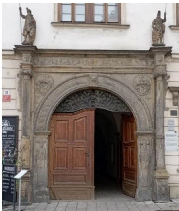
Obr. VII. Olomouc, portál domu v ulici Dolní náměstí č. 39, čp. 27, po 1586
