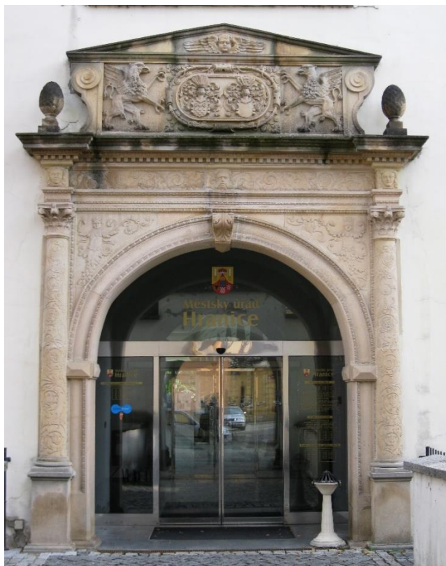
13 – Hranice, zámek, vstupní portál, asi 1594
