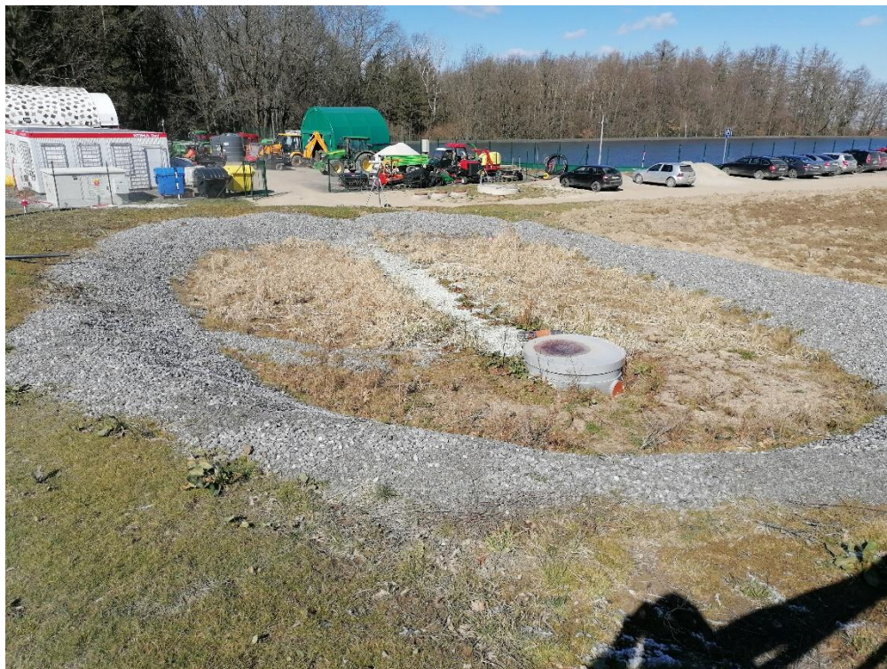
Obr. 6. Nebřenice, KČOV č.10 v provozu
