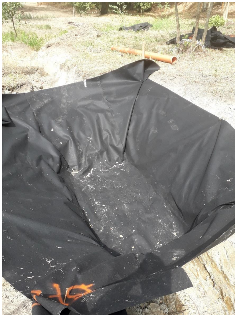
Obr. 8. Nebřenice, KČOV č.4 pokládka základní krycí vrstvy z geotextílie
