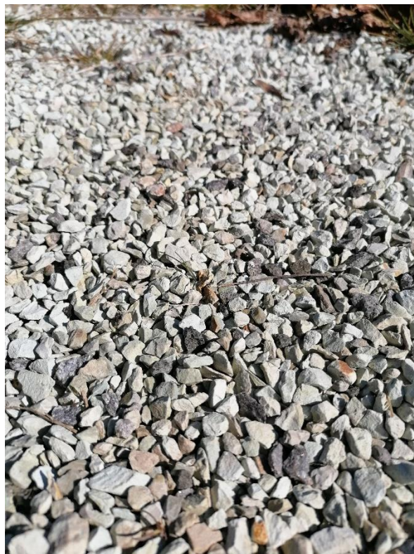
Obr. 10. Nebřenice, KČOV č.10 Zeolit použitý při výstavbě
