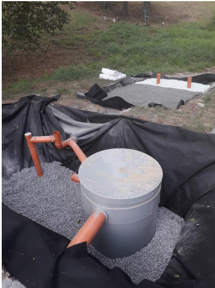
Obr. 7. Nebřenice, KČOV č.2, v průběhu výstavby
