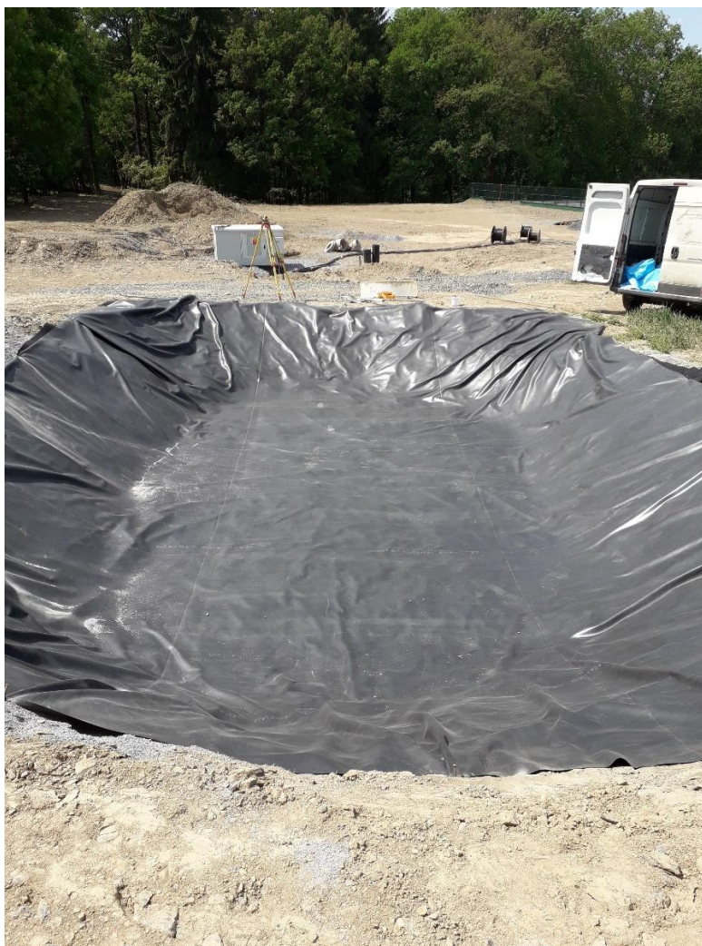
Obr. 9. Nebřenice, KČOV č.10 pokládka nepropustné vrstvy z EPDM
