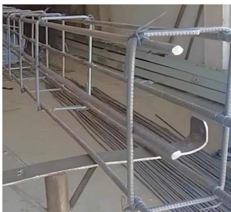
Obrázek 16 – vázací stůl s výztuží ŽB sloupů (ilustrativní foto) [6]
