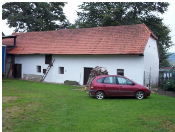
Obrázek 23: Hospodářská budova Vitějovice
