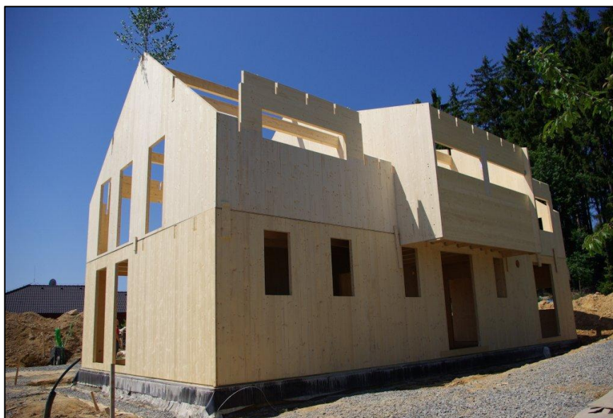
Obr. 5.: Rodinný dům z vrstveného masivního dřeva [ www.novatop-system.cz ].
