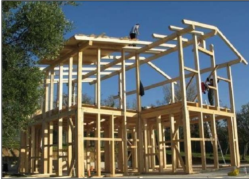
Obr. 8.: Platform-Frame konstrukce [www.jsmillar.com].
