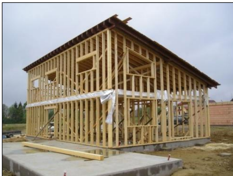
Obr. 3.: Rámová konstrukce rodinného domu [www.woodsystm.cz].
