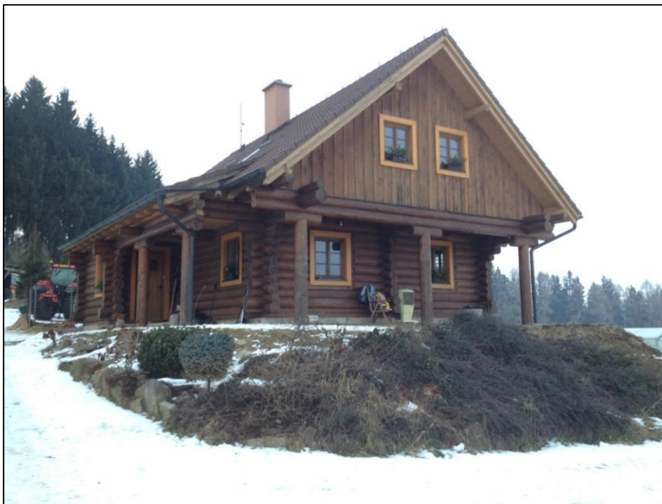
Obr. 18: Srubový dům z kulatiny v obci Podlesí u Miličína, únor 2015.
