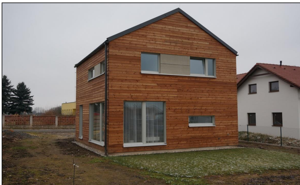
Obr. 15: Prefabrikovaná dřevostavba v obci Olešná, rok 2014 [Chytrý dům s.r.o.].
