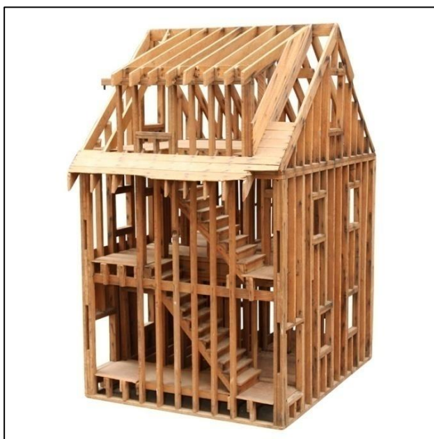
Obr. 7.: Balloon-Frame konstrukce [www.jsmillar.com].
