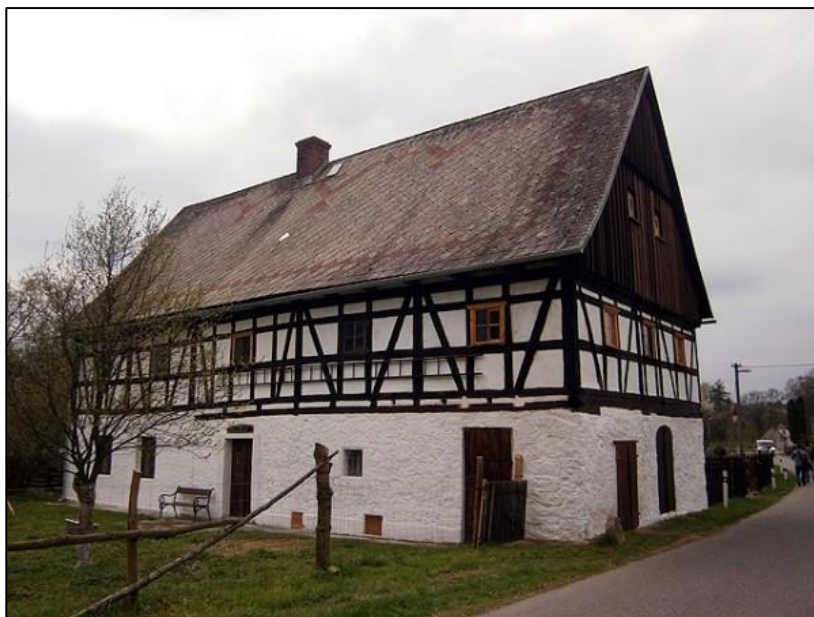
Obr. 11.: Hrázděná konstrukce [www.propamatky.cz].
