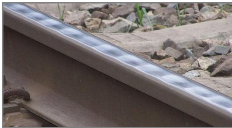
Obr. 2-25 Vlnkovitost kolejnice na trati mezi Brnem a Blanskem [1]
