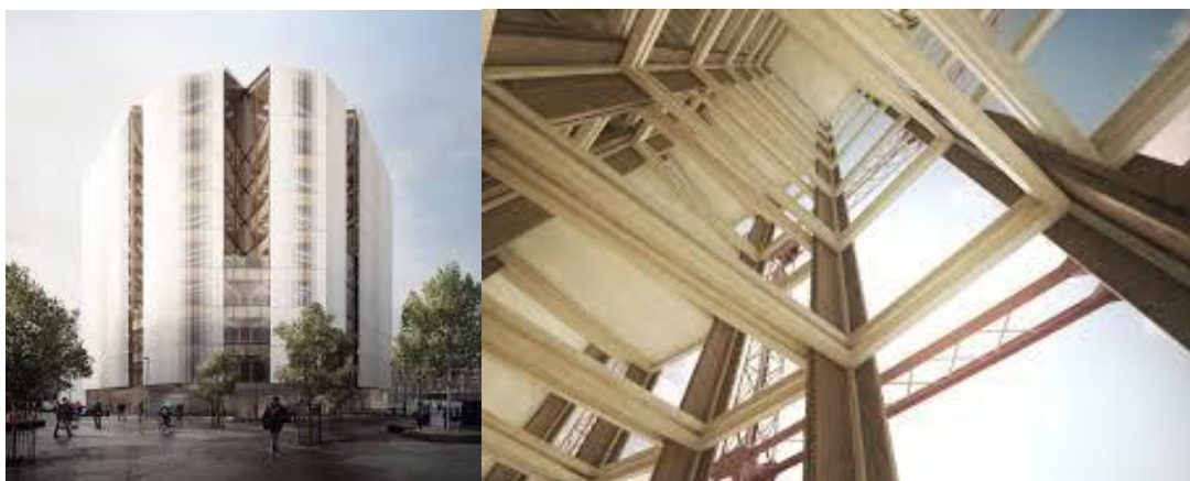
Obrázek 6. Dřevěná budova Shoreditch 30metrů ( www.dezeen.com )
