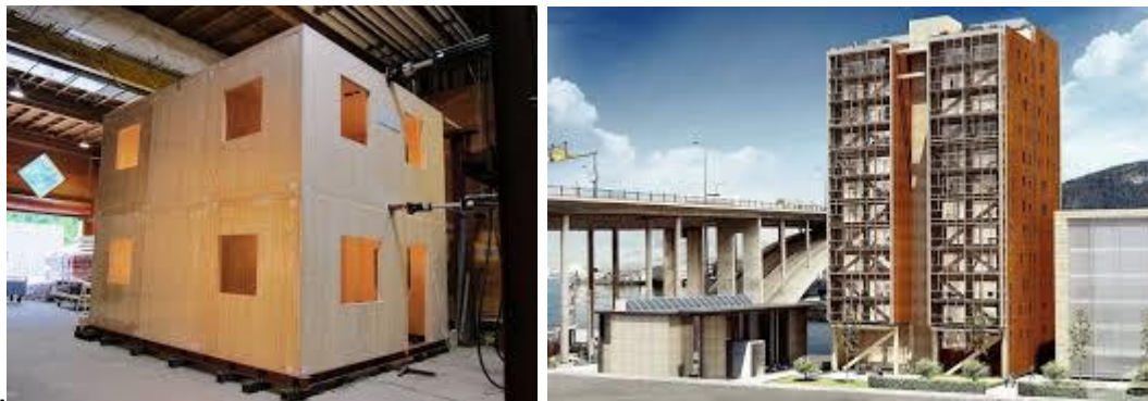
Obrázek 11. Prefabrikace modulů
