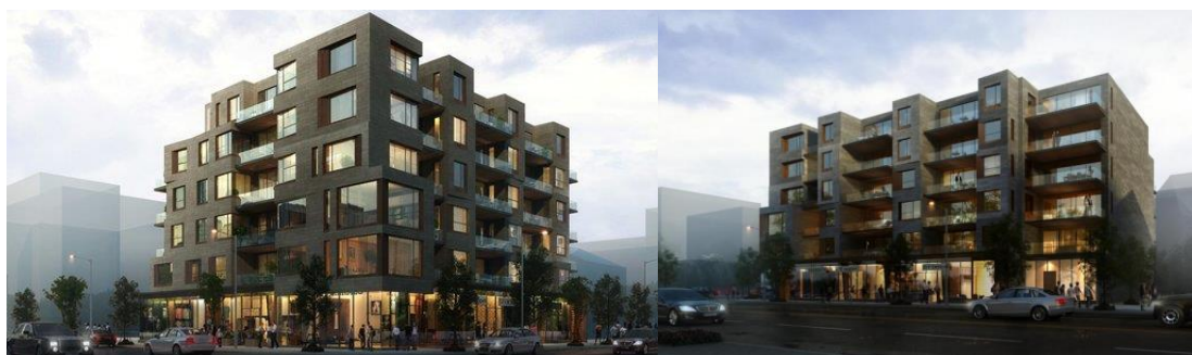
Obrázek 23. Stavba velice estetické a komfortní dřevostavby v centru Berlína (megnaindianrestaurant.net)
