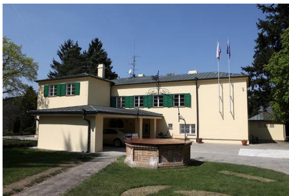
Obrázek č. 22: Současná podoba jihovýchodního průčelí vily s dostavbou ze 70. let, zdroj: vlada.cz
