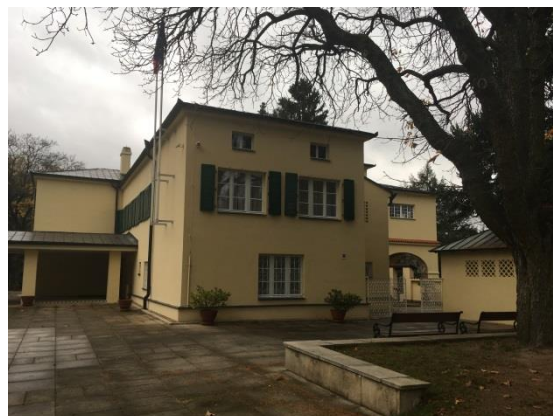
Obrázek č. 20: Současná podoba severovýchodního průčelí, zdroj: vlastní
