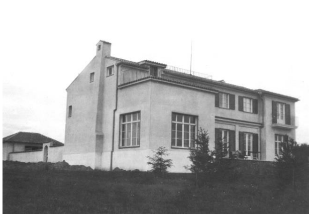
Obrázek č. 15: Severozápadní průčelí v roce 1931 dle původního Kropáčkova návrhu, převzato z (Drha a Kolář, 2004)
