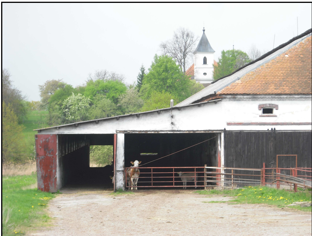
Obr. č. 6 – OMD Hodušín – stará hala
