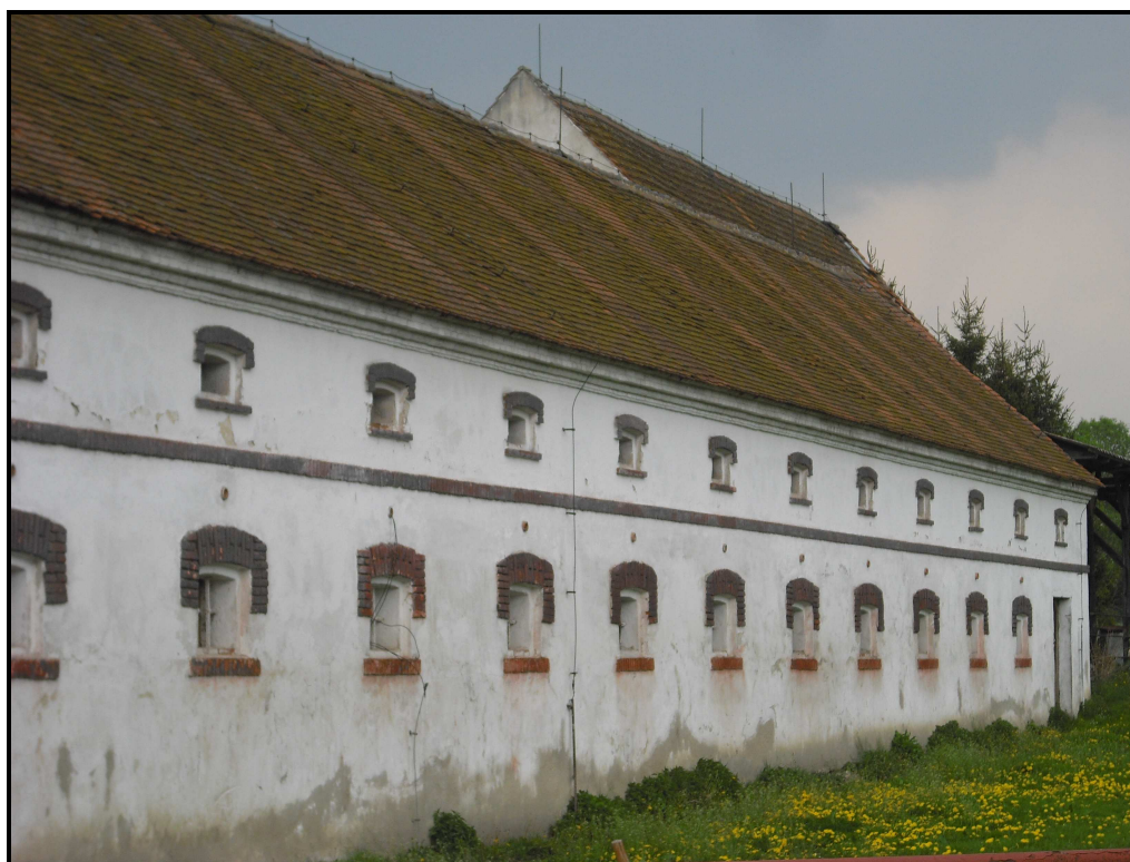
Obr. č. 16 – OMD Hodušín – stará hala
