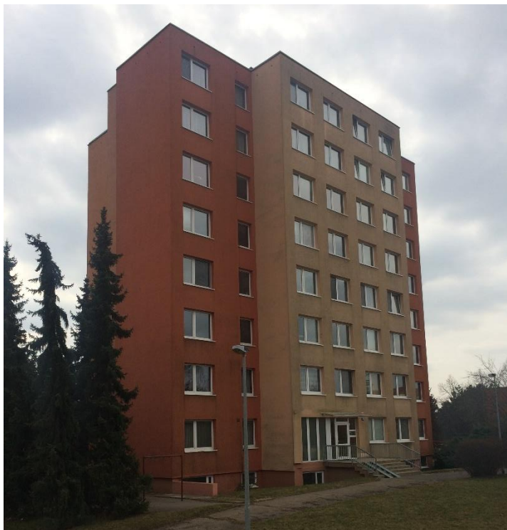
Obrázek 11: Panelový dům, kde probíhalo měření (Zdroj: Autor)
