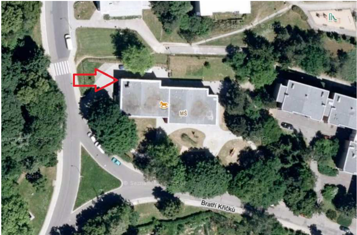
Obrázek č.5 letecký pohled na měřený objekt předškolního zařízení.
