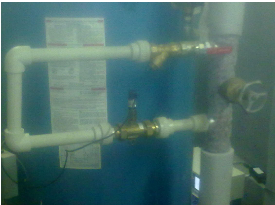
Obrázek č.6 osazení průtokoměru.
