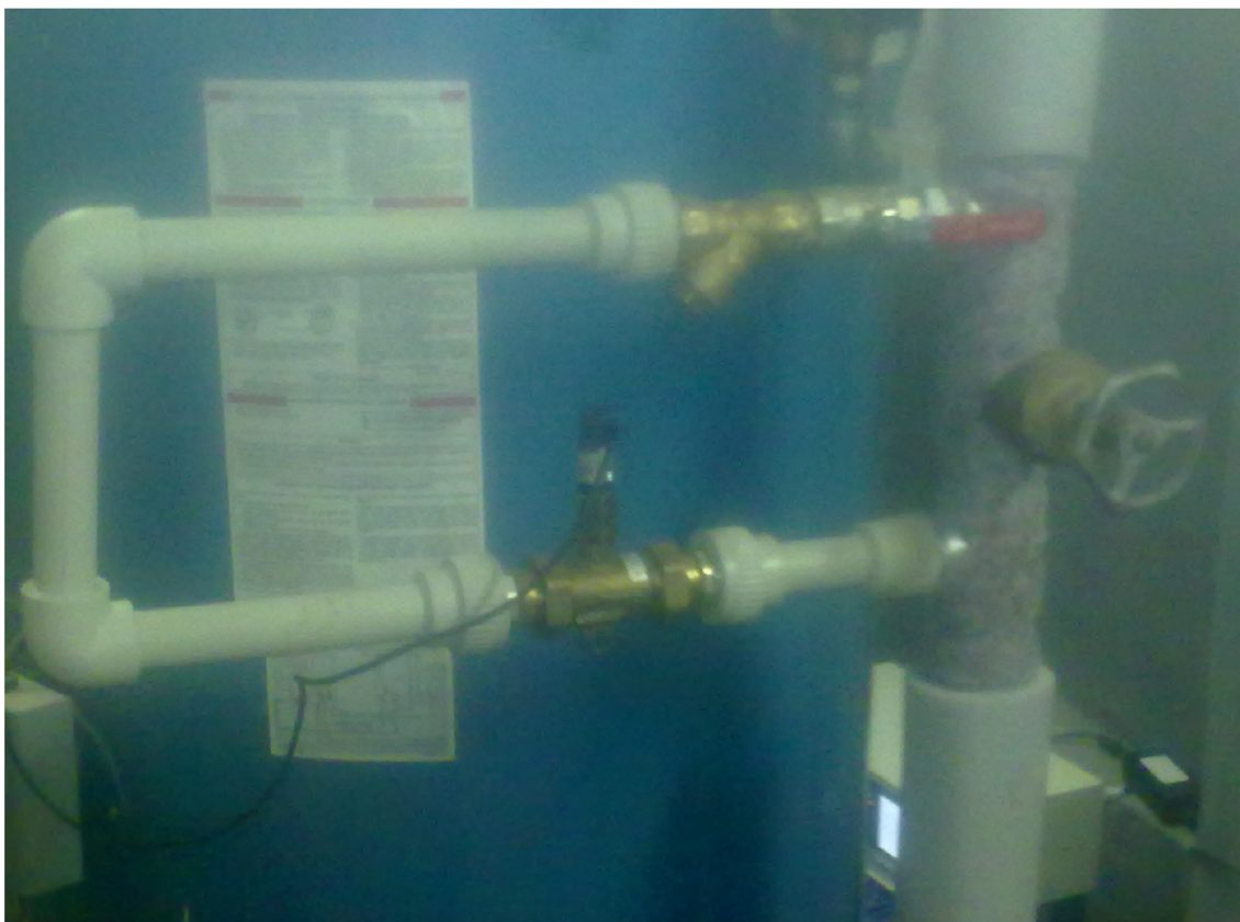
Obrázek č.6 osazení průtokoměru.
