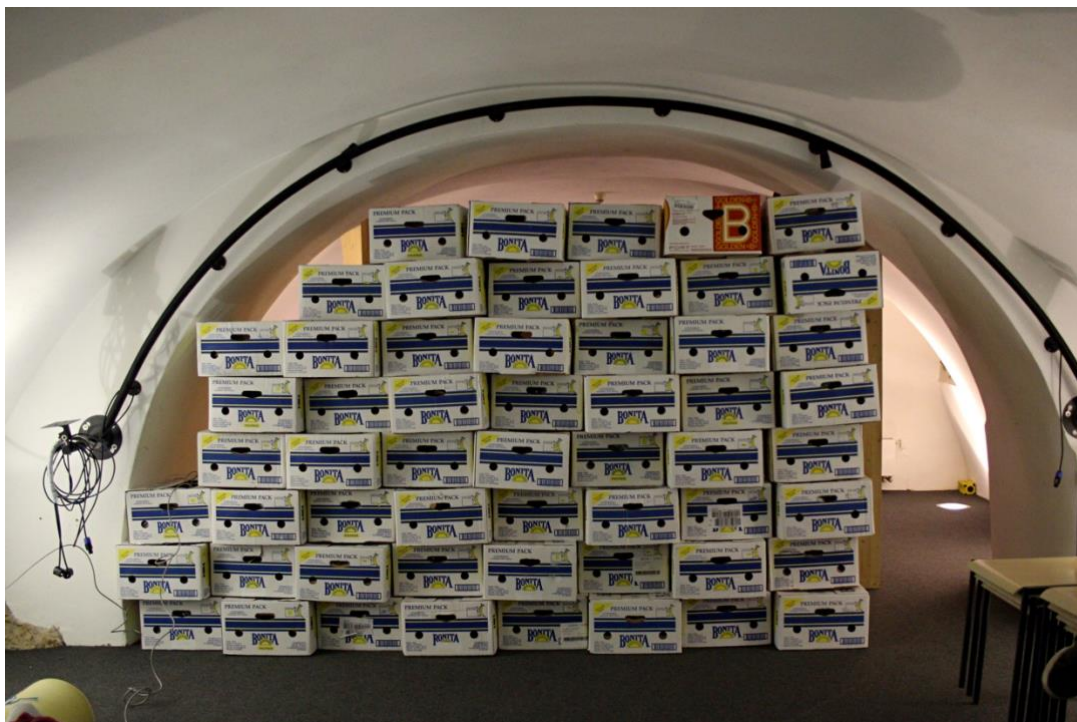
Nekomerční a dobrovolnická stránka studentského vysílání: dočasná podoba nového studia na Konviktu, kam se vysílání přesunulo v roce 2015 - příčka z banánových krabic naplněných papírem.
