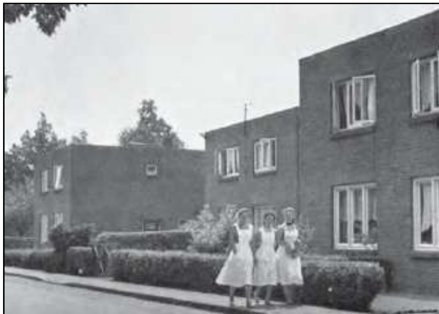
Reeks dubbele woningen aan het Europaplein 12
