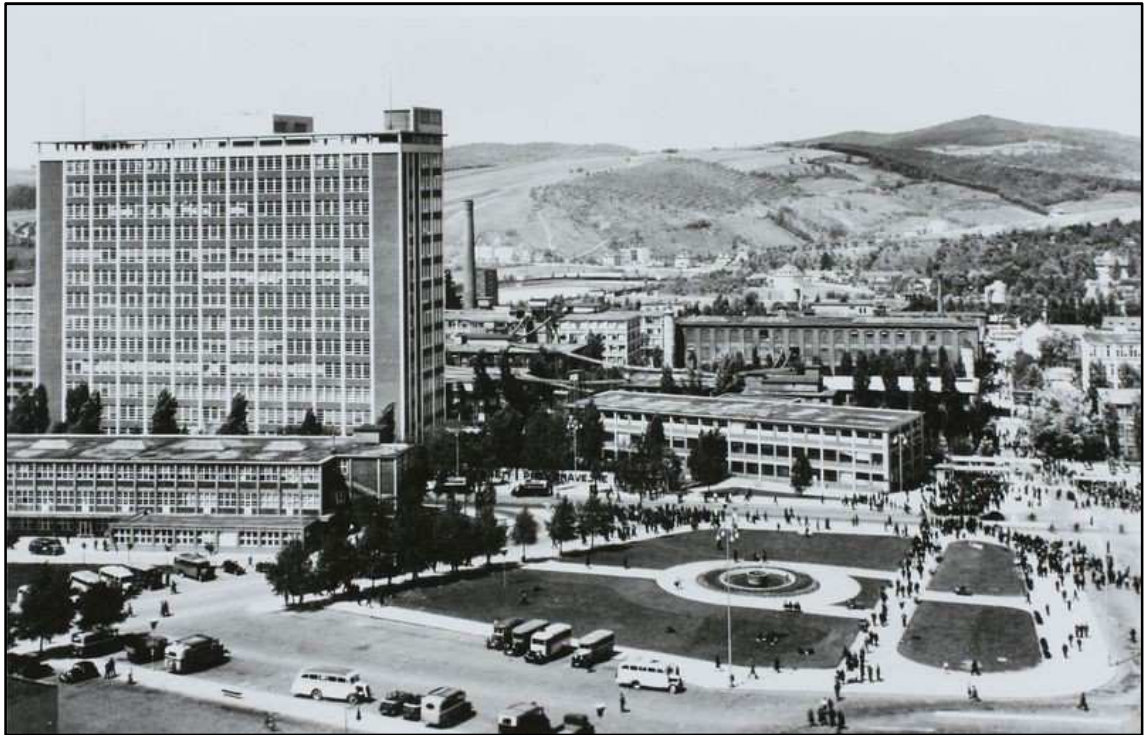
Het gezicht op het fabrieksareaal 17
