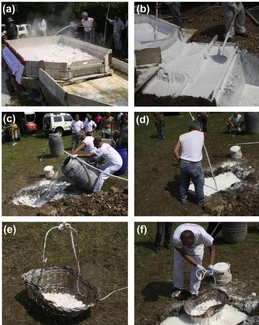
Obr. 3 - Tradiční metody hašení vápna: a, b – přepouštění, c, d – Grande Acqua, e, f – namáčení [2]
