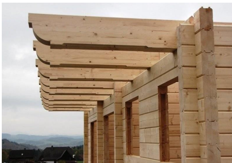
Obr. 8 - stavba srubu z lepených frézovaných profilů (Epls-cz, 2018)
