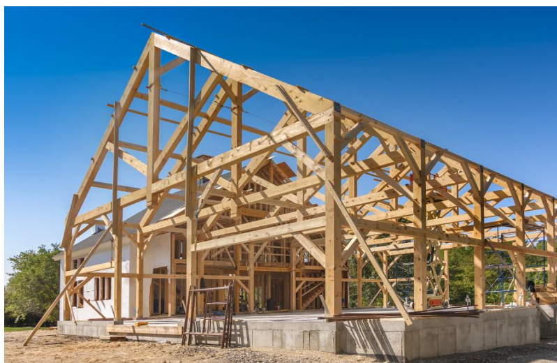
Obr. 13 - stavba těžkého dřevěného skeletu (Estav, 2017)
