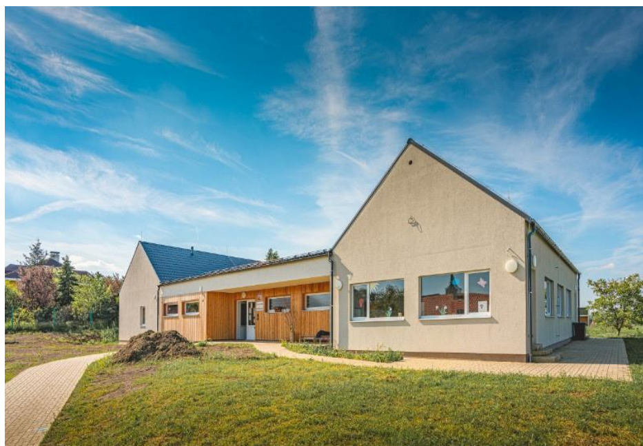
Obr. 17 - celkový pohled na objekt MŠ Líšnice (Haas-Fertigbau, 2019)
