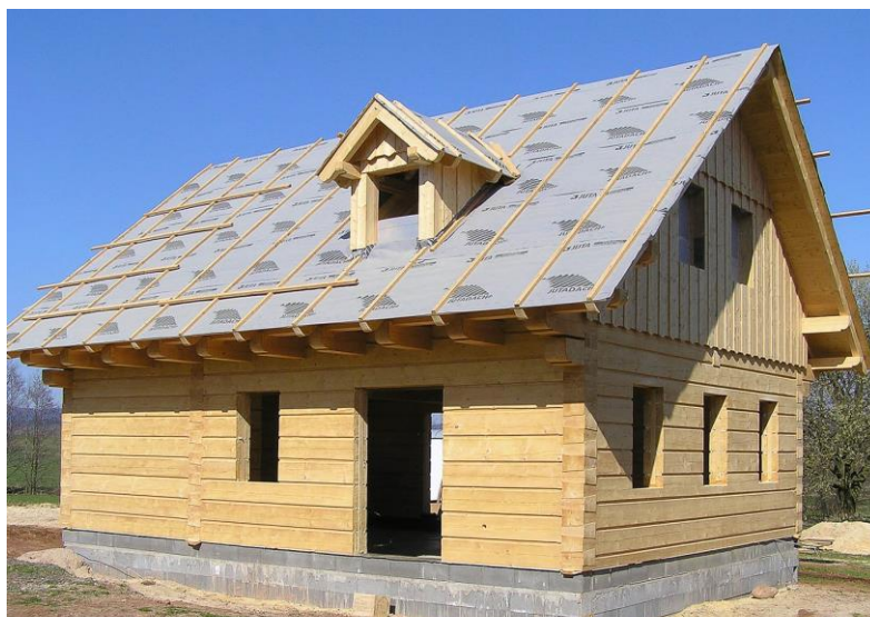
Obr. 7 - stavba srubu z polohraněného řeziva (Epls-cz, 2018)
