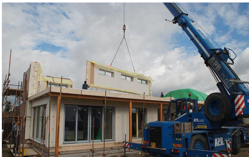
Obr. 12 - montáž panelové dřevostavby (Drevoastavby, 2018)
