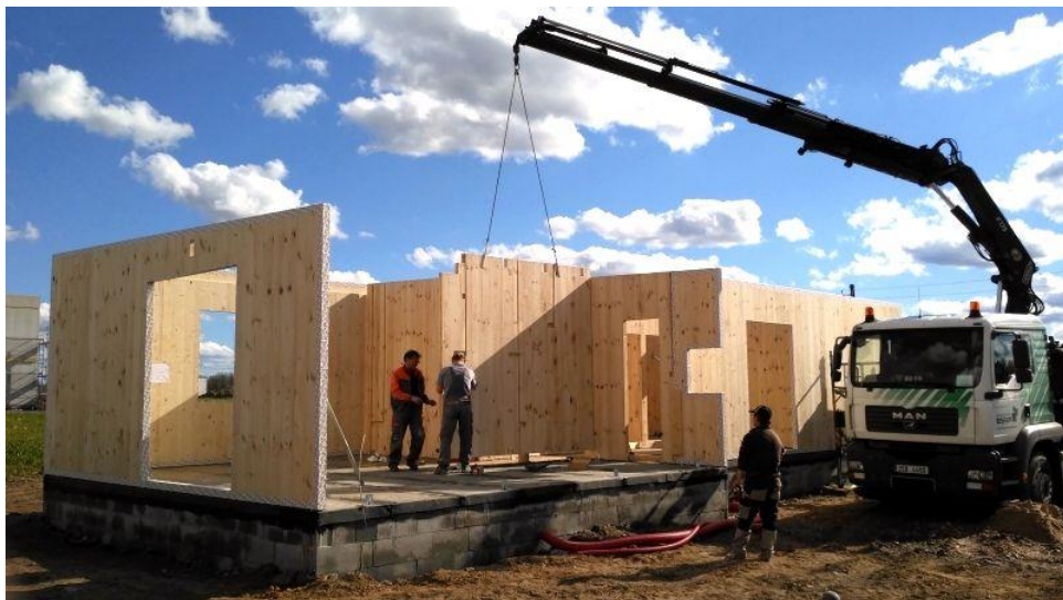
Obr. 14 - ukázka výstavby pomocí CLT technologie (Drevoastavby, 2017)
