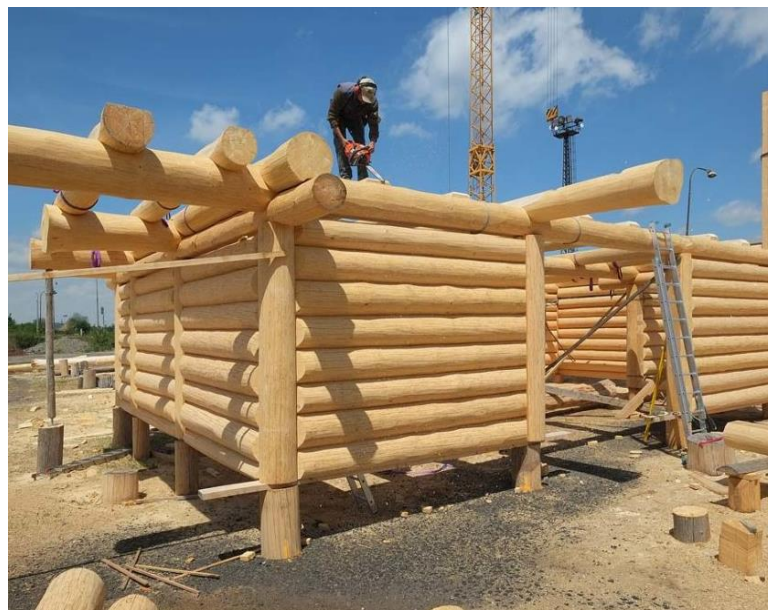
Obr. 6 - stavba srubu z tesané kulatiny (Masivprodukt, 2019)
