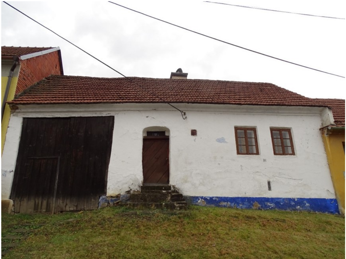
Foto č. 6: Uliční průčelí objektu č. p. 121.
