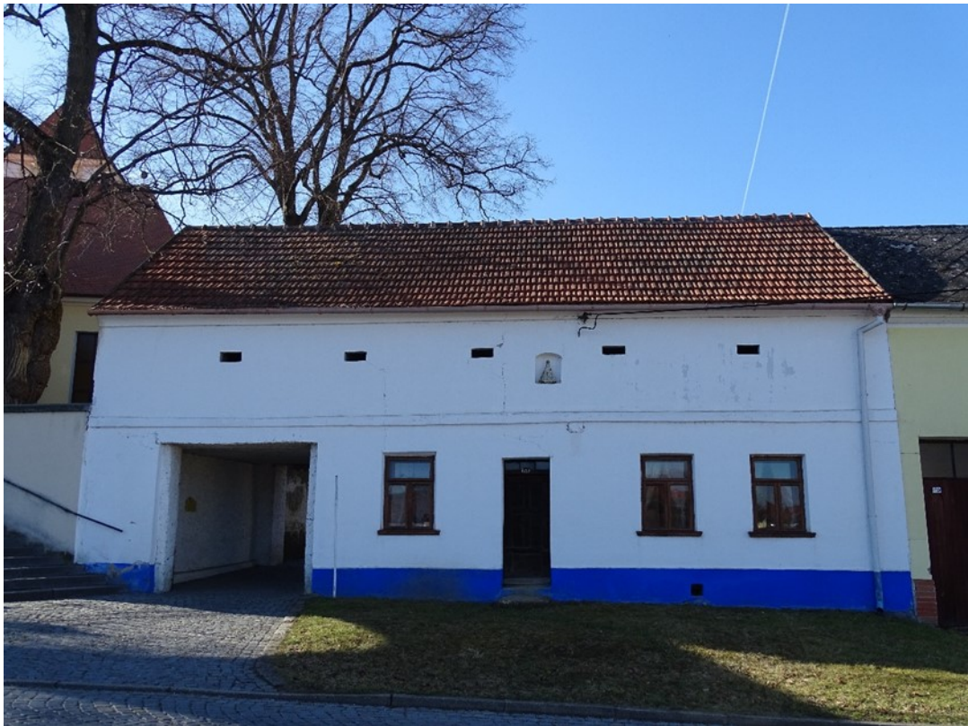
Foto č. 9: Uliční průčelí objektu č. p. 739.
