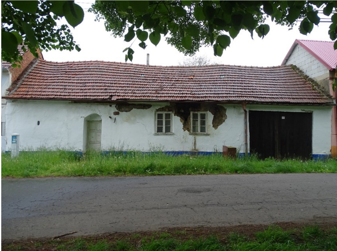
Foto č. 2: Uliční průčelí objektu č. p. 49.
