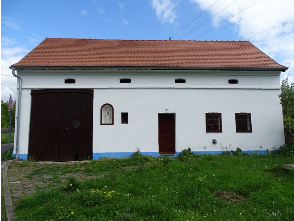
Foto č. 1: Uliční průčelí objektu č. p. 14.
