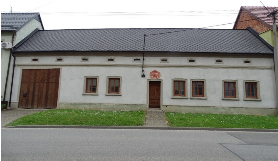
Foto č. 8: Uliční průčelí č. p. 131.
