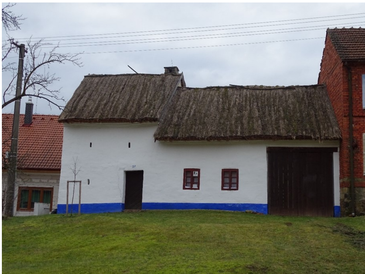
Foto č. 3: Uliční průčelí objektu č. p. 57.
