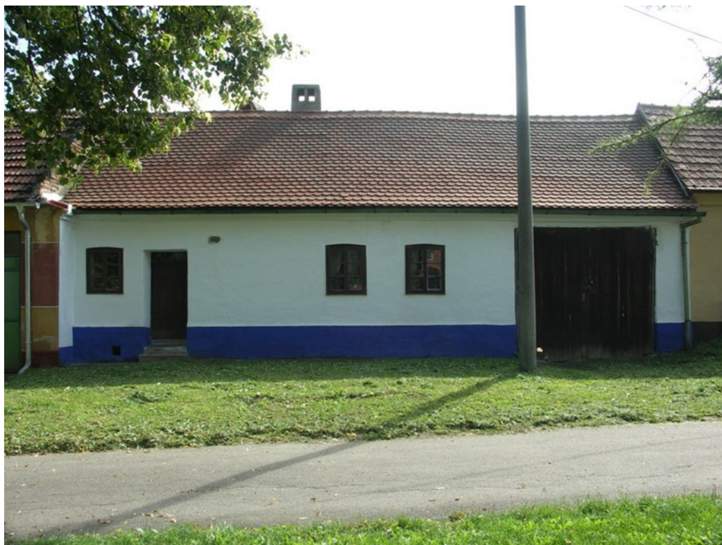
Foto č. 4: Uliční průčelí objektu č. p. 65.
