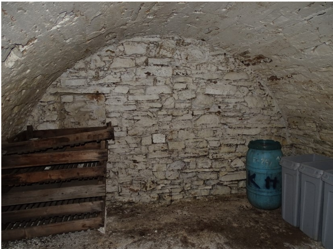
Foto č. 7: Sklepní prostora objektu č. p. 121, pohled na západní stěnu.
