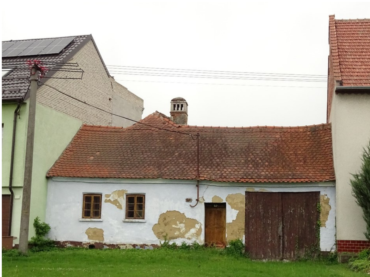
Foto č. 5: Uliční průčelí objektu č. p. 69.
