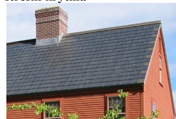
Obrázek č. 11 - Samotná střešní krytina
