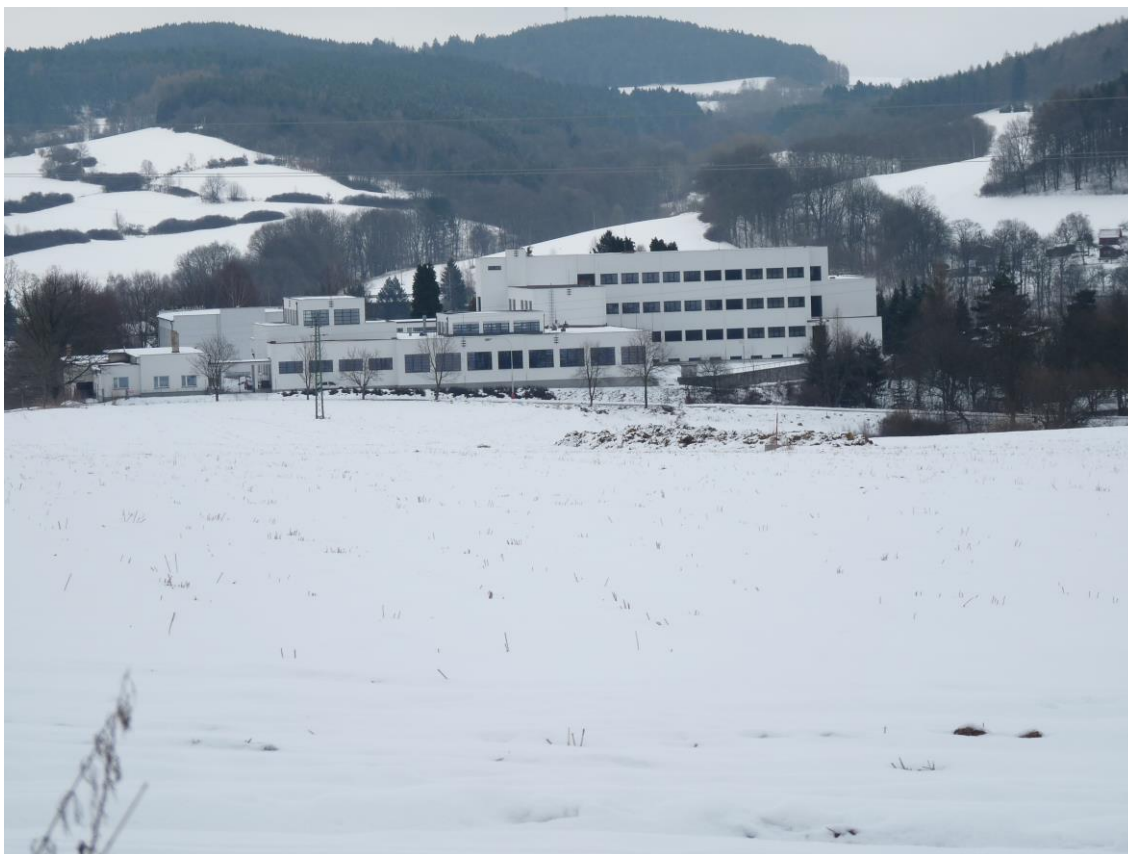
Areál čp. 440 v Resslově ulici, kde škola sídlí od roku 1933.
