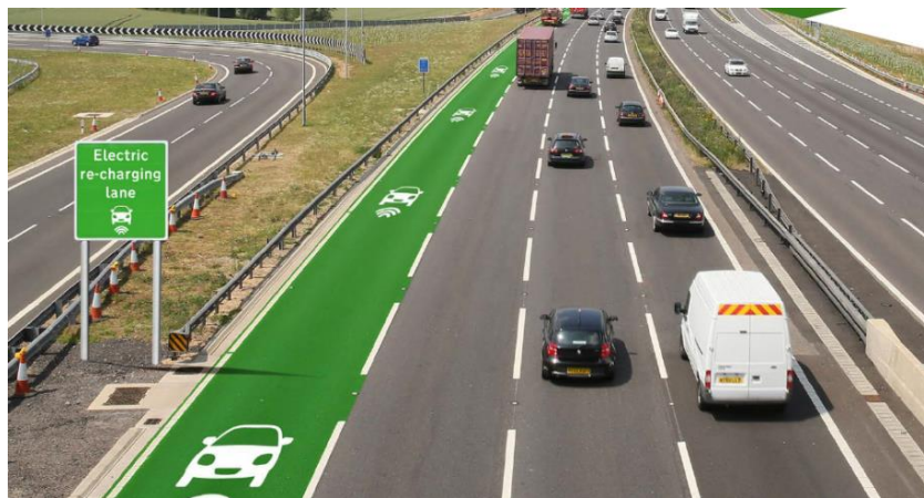
Obr. 9 Vizualizace dynamického indukčního nabíjení [34]
