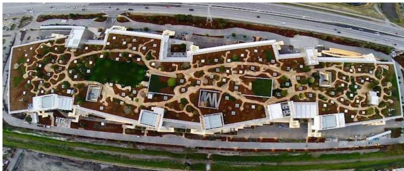
Obr.č.25: Letecká snímka strechy (zdroj: assets, 2015)
