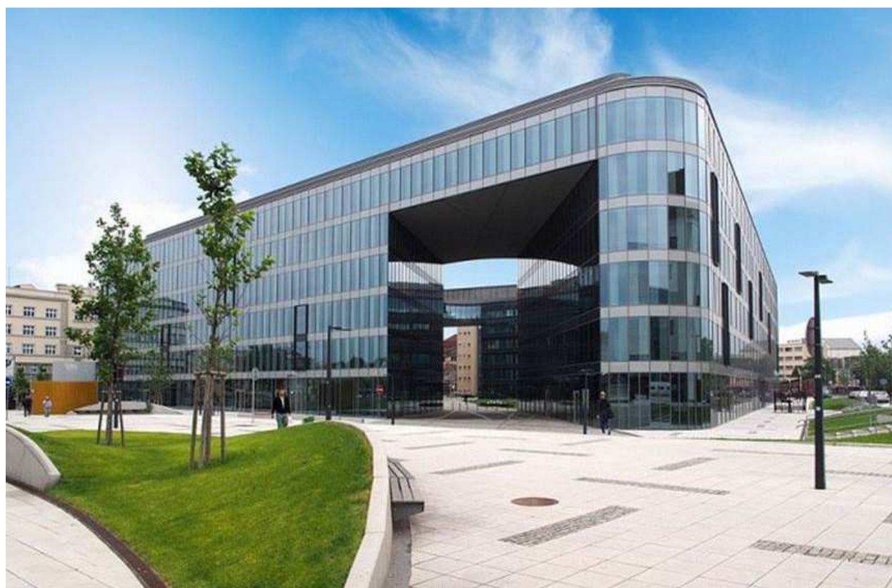
Obr.č.8: Vstup do vnútrobloku (zdroj: officemap, 2013)
