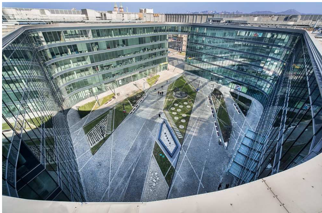
Obr.č.7: Pohľad zo strechy kancelárskej budovy (zdroj: novakarolinapark, 2012)
