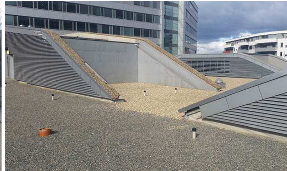
Obr.č.51: Odvetrávacie prvky a odvodnenie (foto: autor)
