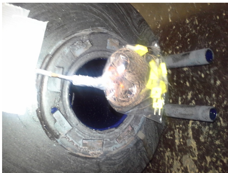
Obrázek 4 - ochrana před vypěněním
