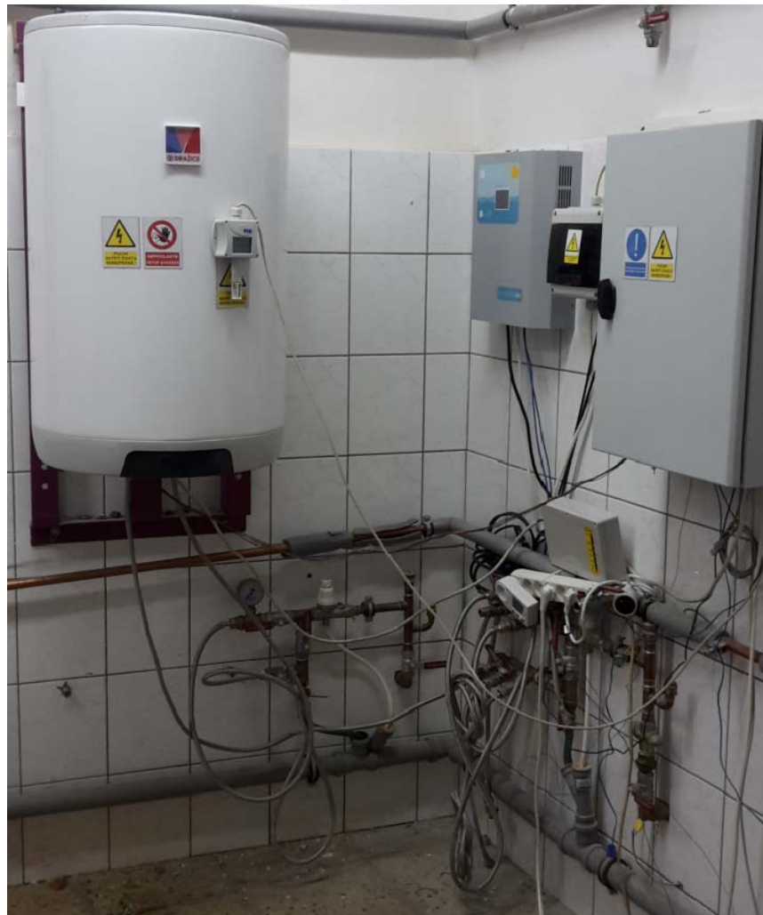
Obrázek 6 - Zapojení ohřívače OKCE 100 v laboratoři DZD
