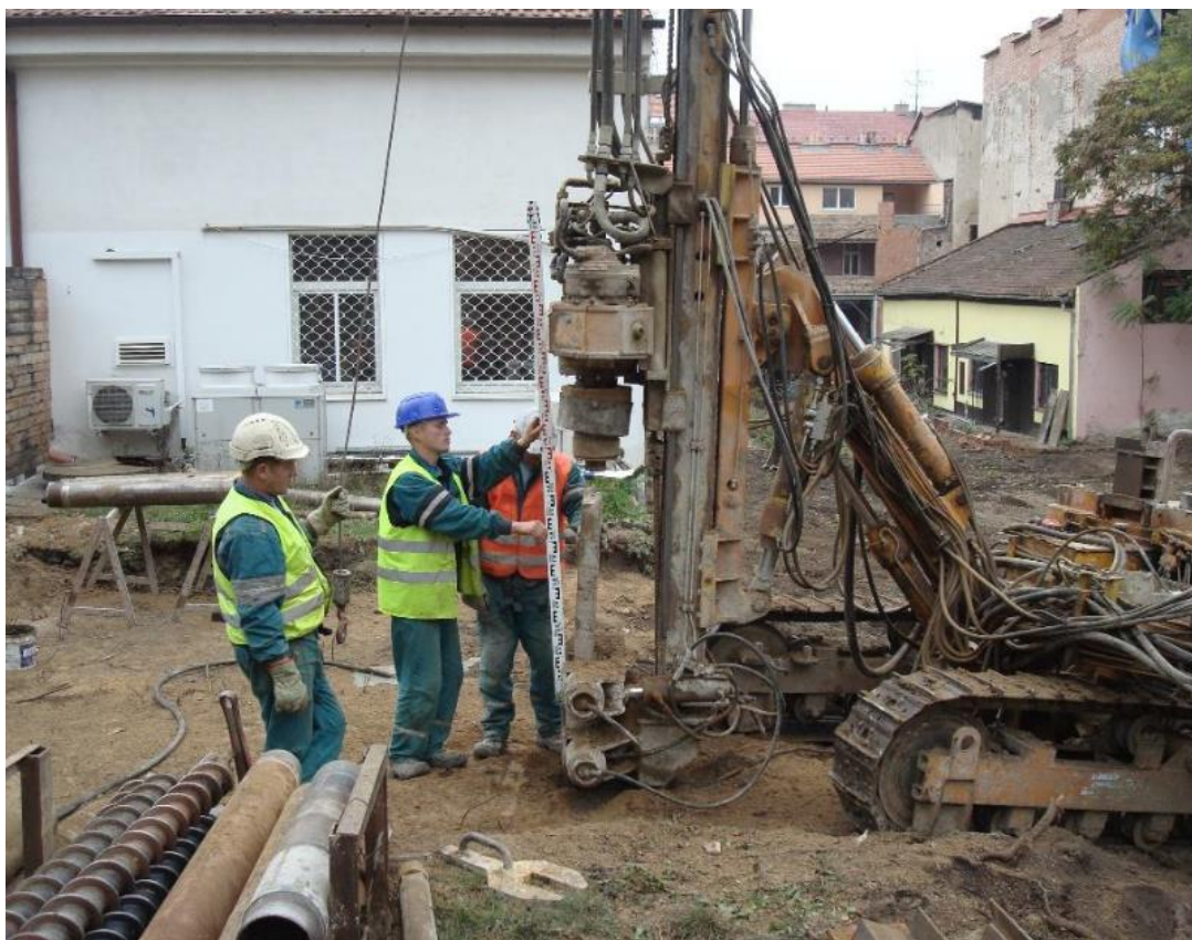
Obr. č. 19 Vlastní provádění zemních vrtů [21]
