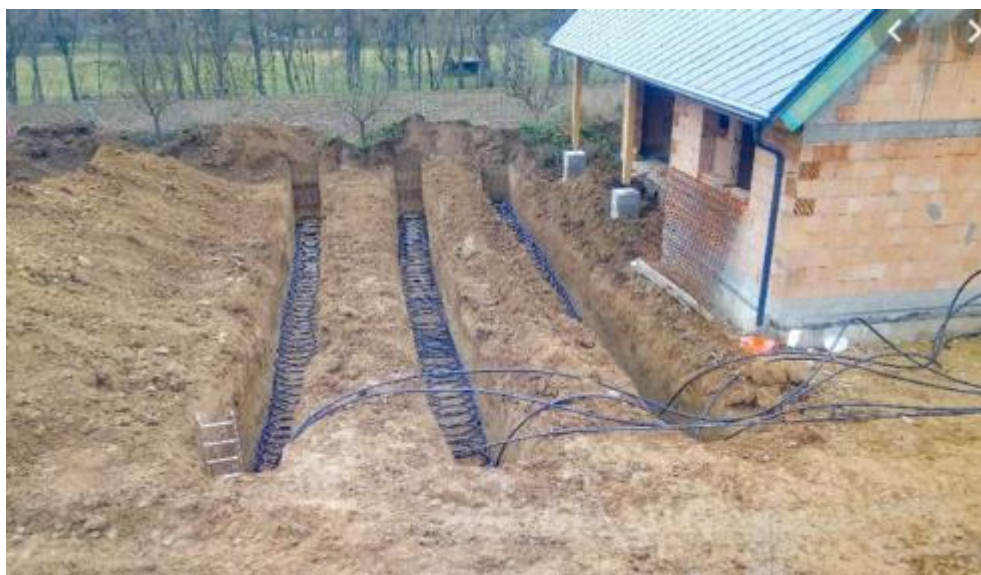
Obr. č. 9 Příklad realizace plošných kolektorů [14]
