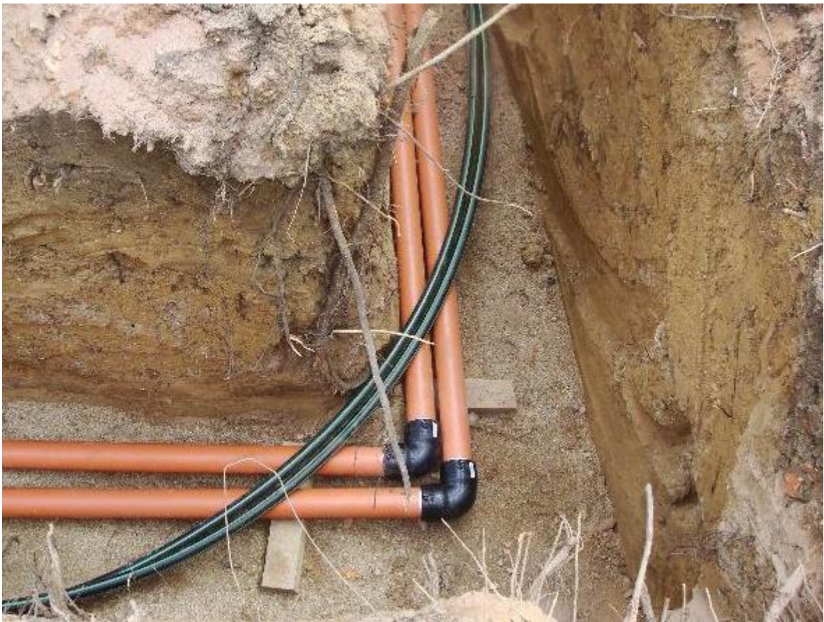
Obr. č. 20 Vedení horizontálního vedení k zemním vrtům [21]
