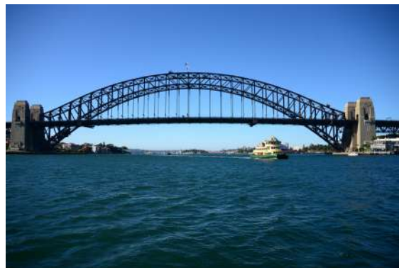
(b) Sydney Harbour Bridge, představitel obloukových mostů s obloukovou konstrukcí; autor obrázku Navin Sigamany 8
