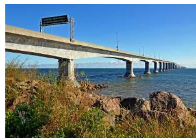
Obrázek 2.10: Trámový most zvaný Confederation Bridge, součást Transkanadské dálnice; autor obrázku Dennis Jarvis 6
