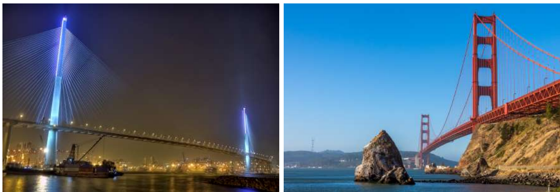
(a) Zavěšený most jménem Stonecutters Bridge ve městě Hong Kong; autor obrázku Edward Wong 9 (b) Golden Gate Bridge, visutý most postavený ve městě San Francisco; autor obrázku Anand Dandekar 10
