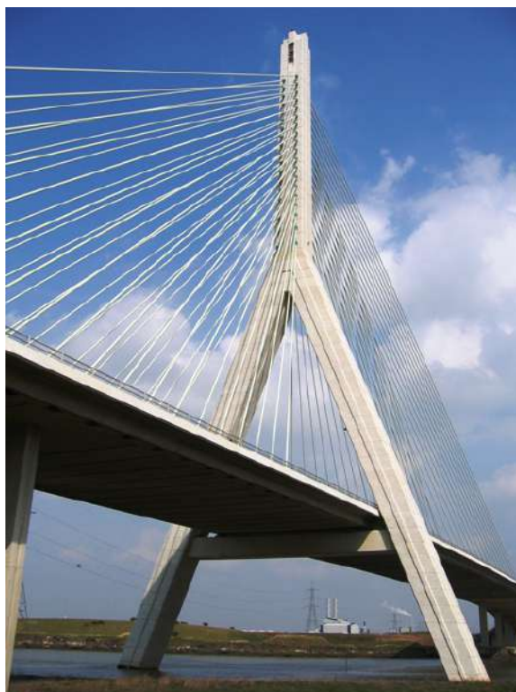
Obrázek 5.2: Fotografie věže mostu Flintshire Bridge 1
