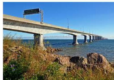
Obrázek 2.10: Trémový most zvaný Confederation Bridge, součást Transkanadské dálnice; autor obrázku Dennis Jarvis 6
