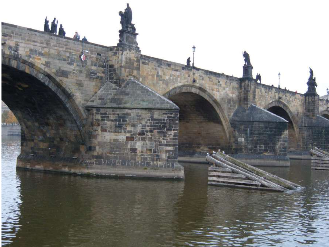
Obrázek 2.8: Ledolamy Karlova mostu v Praze, autorem je uživatel BrokenSphere 5
