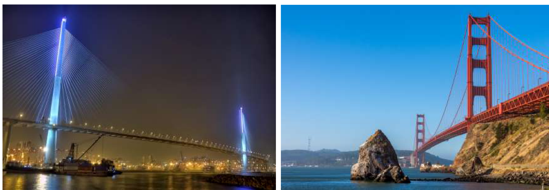
(a) Zavěšený most jménem Stonecutters Bridge ve městě Hong Kong; autor obrázku Edward Wong 9 (b) Golden Gate Bridge, visutý most postavený ve městě San Francisco; autor obrázku Anand Dandekar 10
