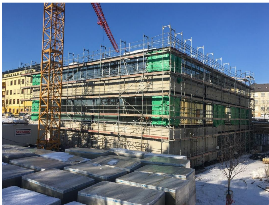
Obrázek 10 - Hrubá stavba, zdroj: Oberstein
