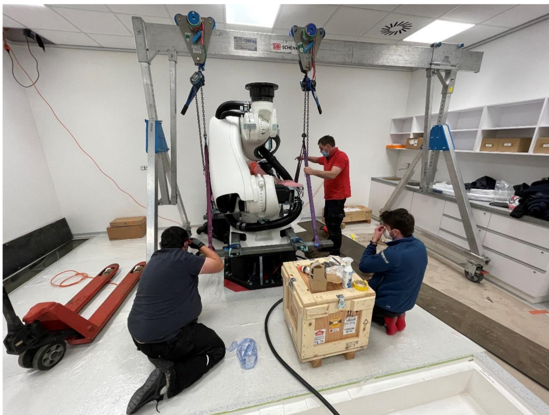
Obrázek 14 - Ukotvení přístroje do podlahy, zdroj: Oberstein
