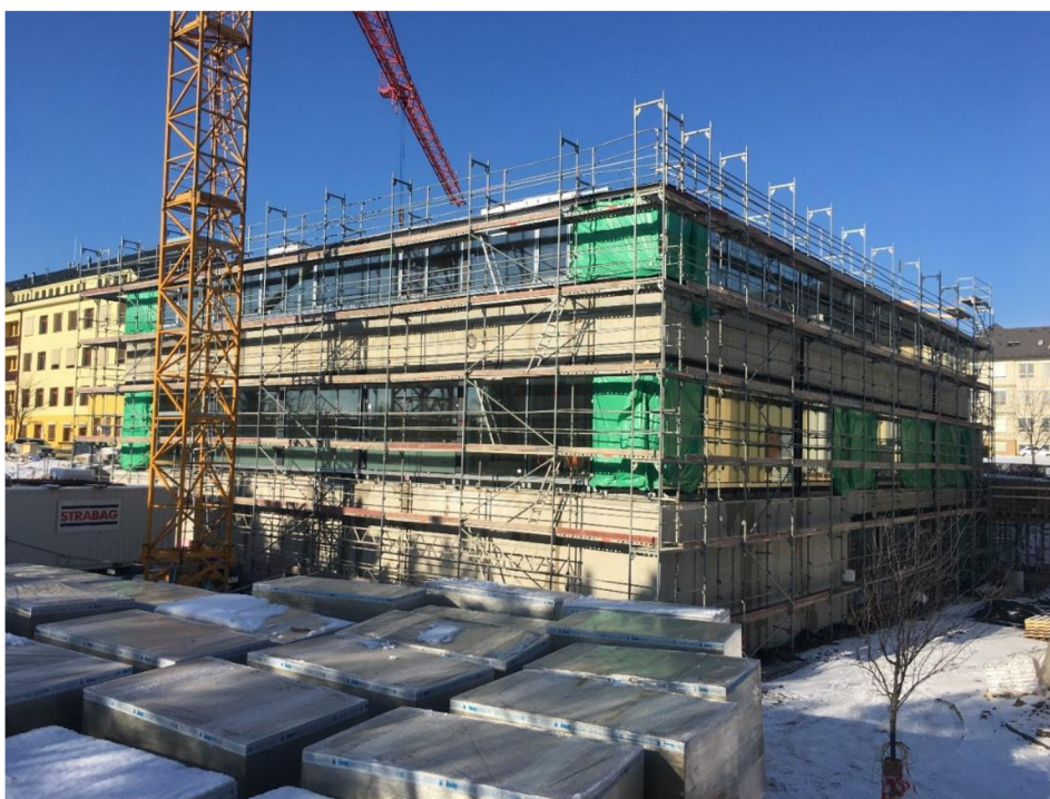
Obrázek 10 - Hrubá stavba, zdroj: Oberstein
