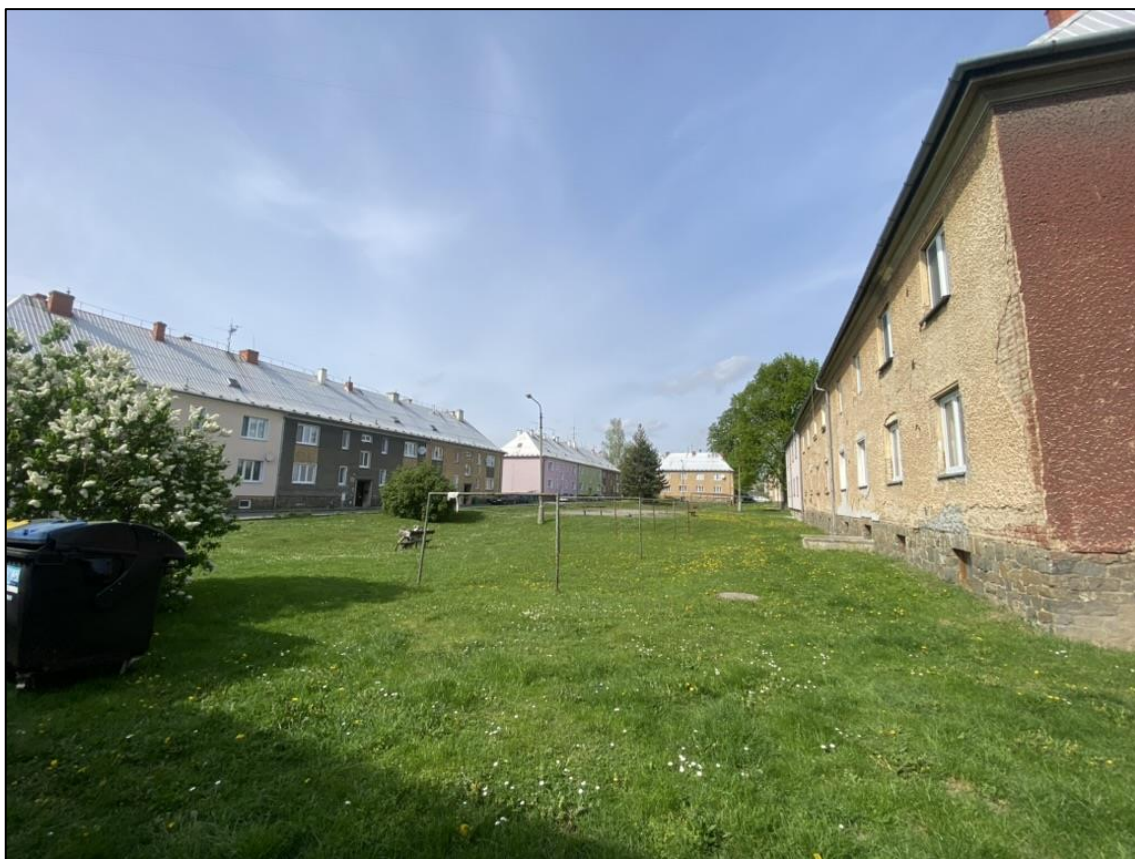
Příloha 5: Vnitroblok na ulici Hlubčická č. p. 109–139 (plánováno) (vlastní fotografie)
