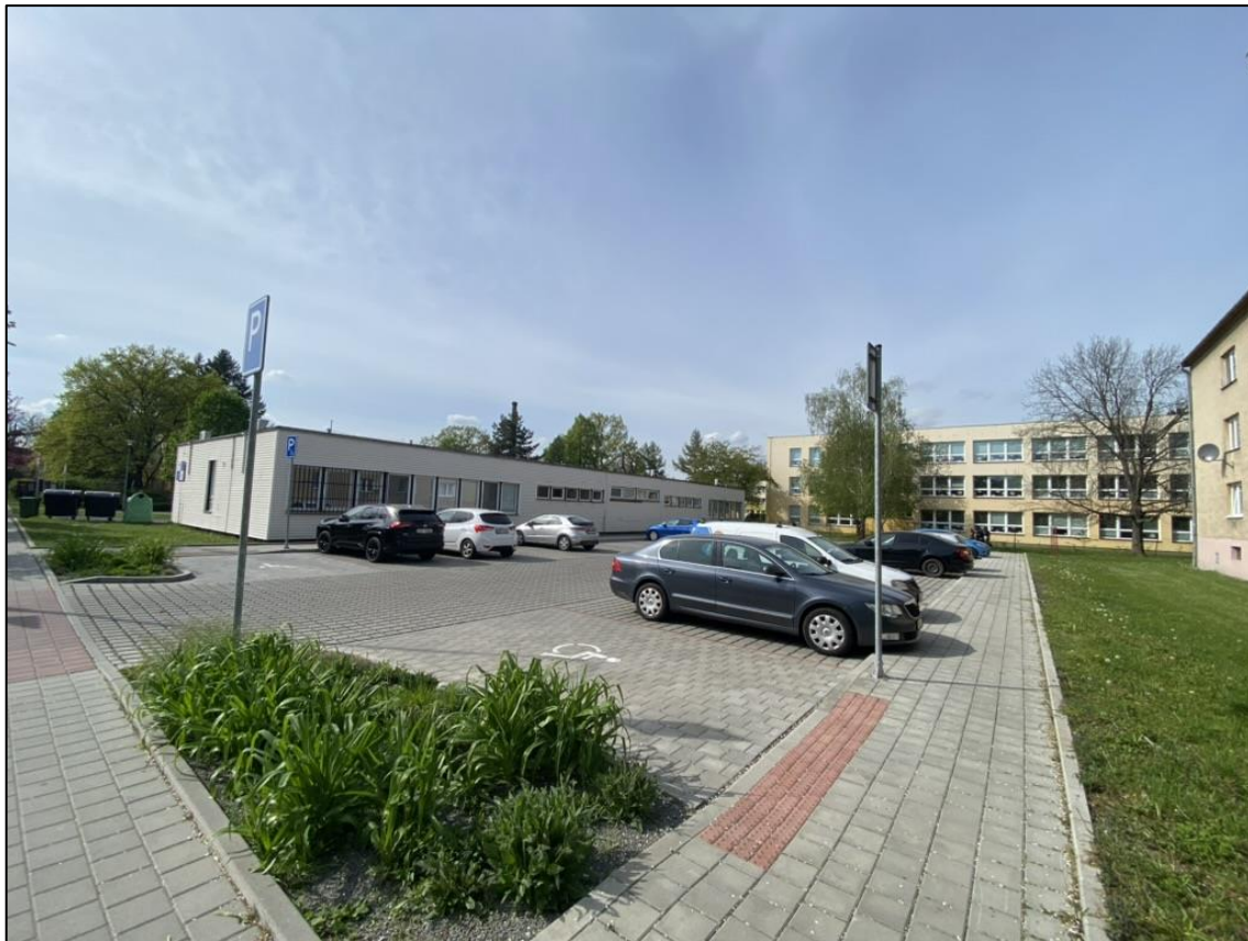
Příloha 12: Nové parkoviště na ulici Žižkova (realizováno) (vlastní fotografie)
